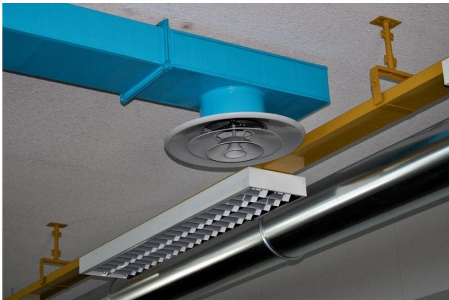
Figura 3.2: Foto dei terminali dell'impianto preesistente (anemostati)
