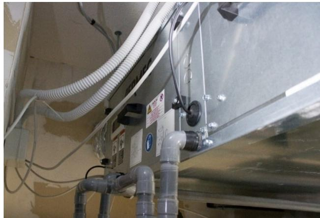
Figura 3.3: dettaglio del recuperatore termodinamico Aermec RTD11 dal controsoffitto
