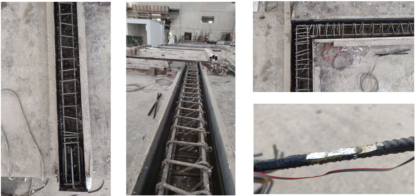
Figura 3.24 – Immagini che sintetizzano la realizzazione del telaio in calcestruzzo armato
