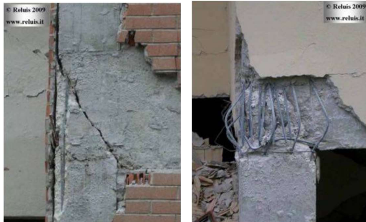
Figura 1.10 (a) – Crisi nodale avvenuta durante l'evento sismico in Abruzzo nel 2006
