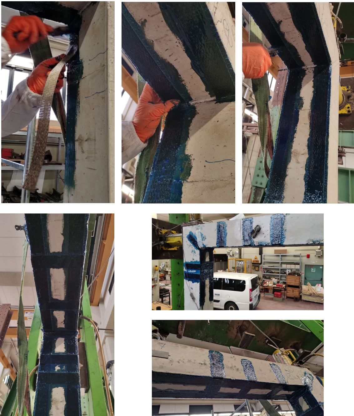
Figura 3.33 – Messa in opera delle fasce rinforzanti
