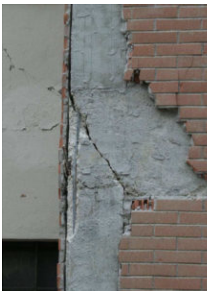
Figura 1.15 – Rottura nodo in C.A. per superamento resistenza a trazione
