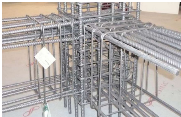
Figura 1.18– Armatura nodo esterno in condizioni sismiche
