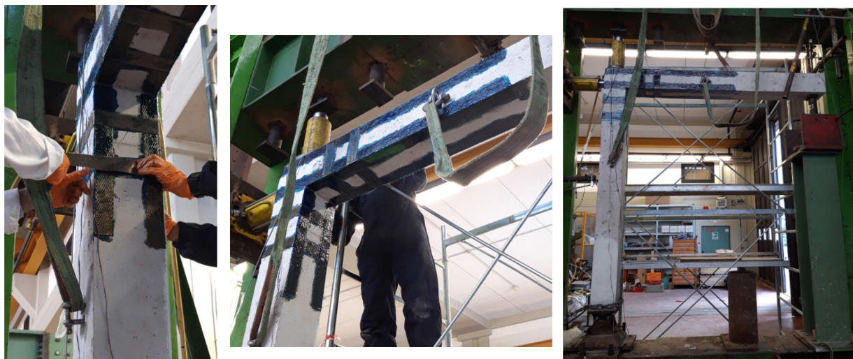
Figura 3.22 – (da sinistra) Cerchiatura del pilastro, applicazione del secondo strato di matrice, telaio rinforzato
