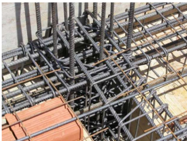
Figura 1.17– Armatura nodo interno in condizioni sismiche
