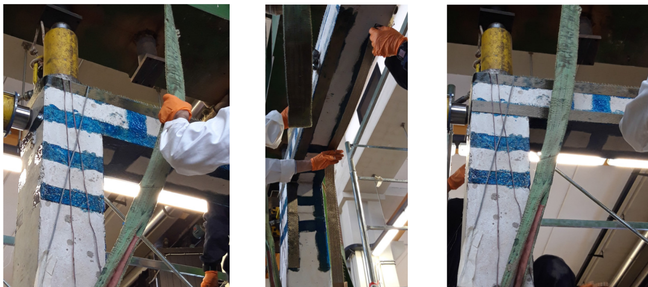
Figura 3.21 – Applicazione del tessuto in fibre di basalto
