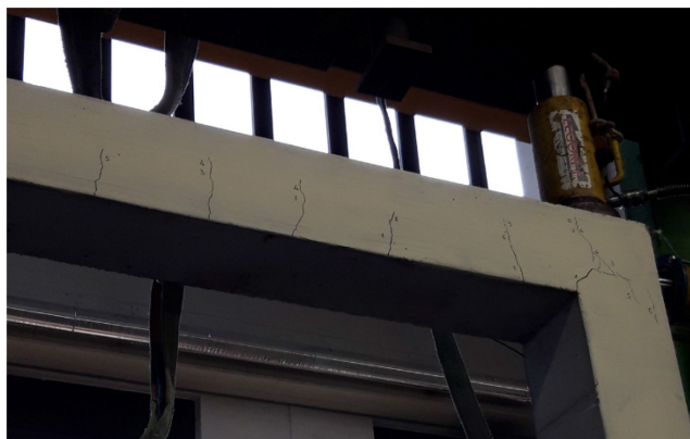
Figura 3.14 – Telaio fessurato al termine della prima prova
