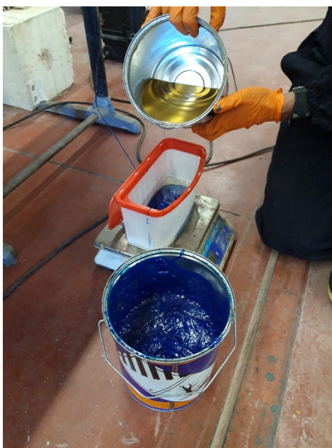
Figura 3.19 – Aggiunta del componente B al componente A
