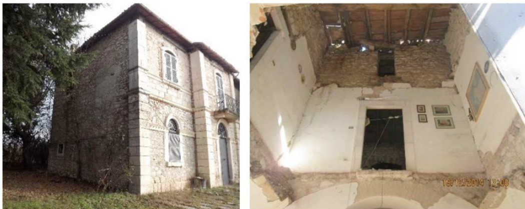
Figura 30 - MUR-1 – Edifici in muratura “antico” – Poggio Piaccenze (AQ).
