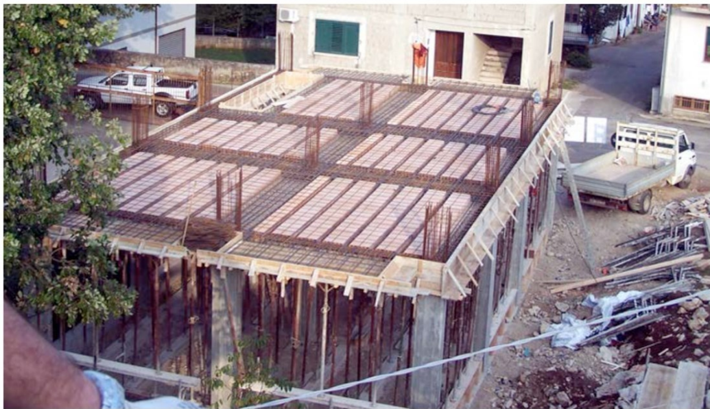
Figura 40 - CA-4 – Edificio in costruzione, progettato dopo l'entrata in vigore delle norme sismiche – San Gregorio Magno (SA).
