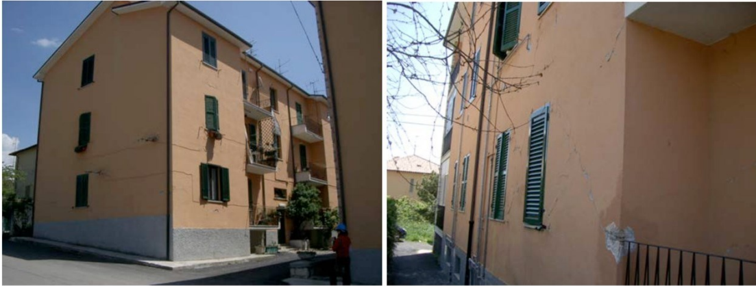
Figura 32 - MUR-3 – Edificio in muratura “moderno” – L'Aquila.
