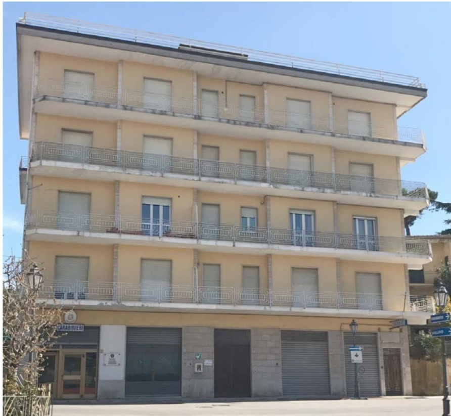
Figura 39 - CA-3 – Edificio costruito tra il 1971 e l’entrata in vigore delle norme sismiche – Paternopoli (AV).
