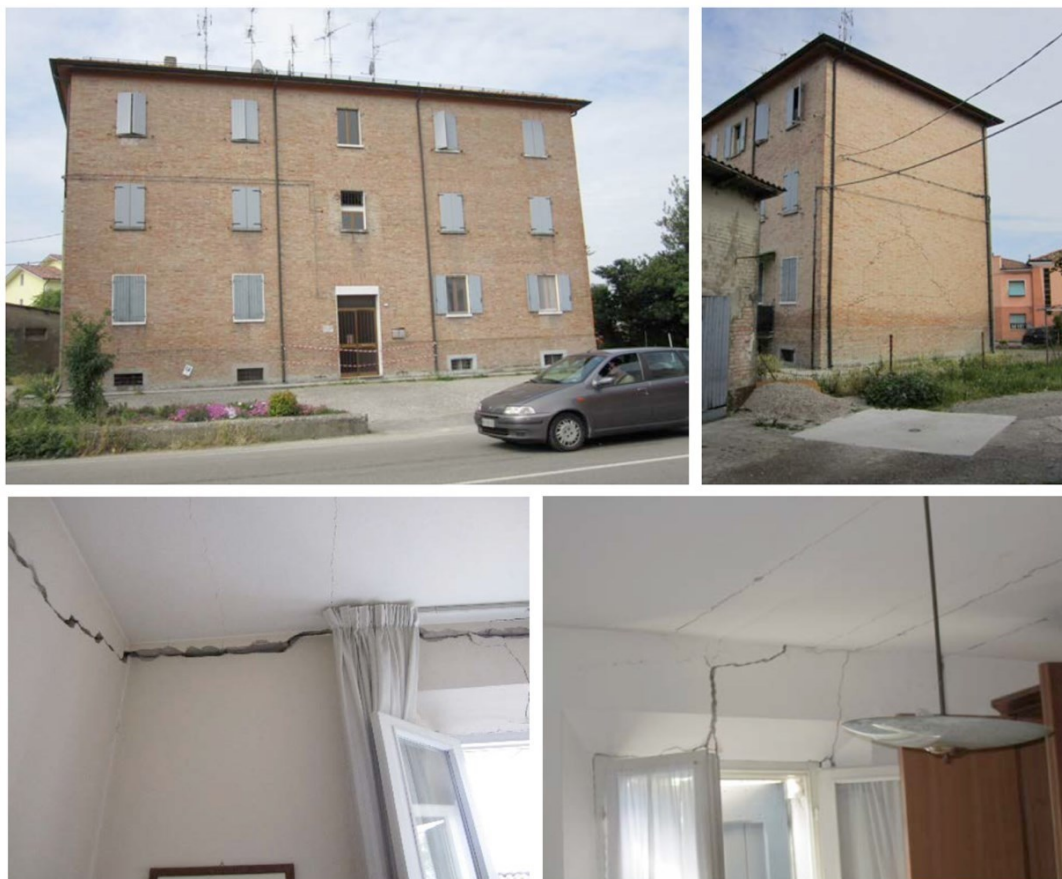
Figura 36 - MUR-5 – Edificio in muratura “moderno non a norma” – Mirandola (MO).
