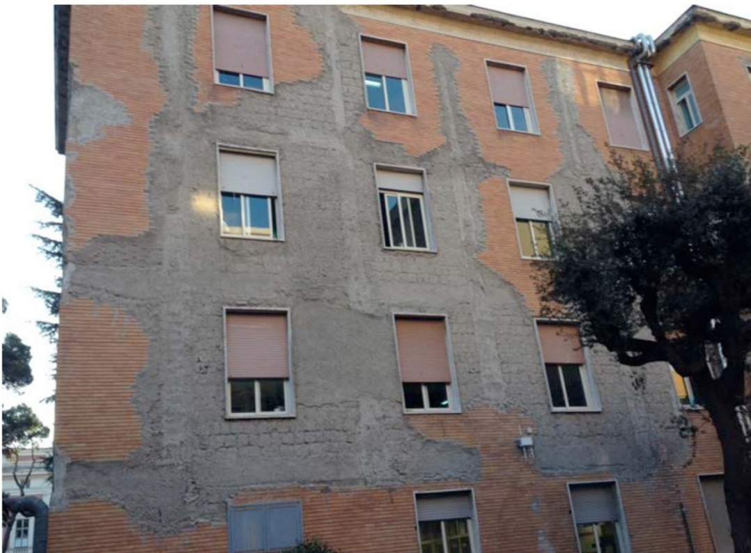
Figura 37 - CA-I – Edificio in c.a. costruito prima del 1939 – Napoli.
