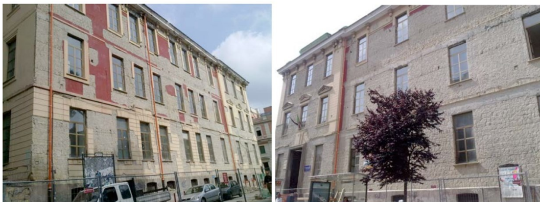
Figura 34 - MUR-4 – Edificio in muratura “semi-moderno” – Napoli.
