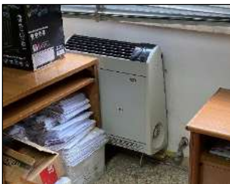
Figura 24: ventilconvettore
