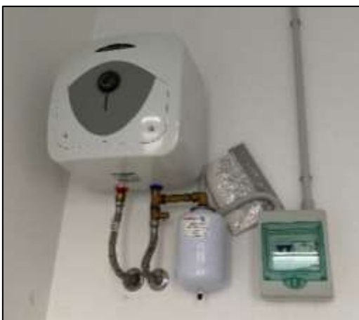
Figura 29: Scaldacqua elettrico
