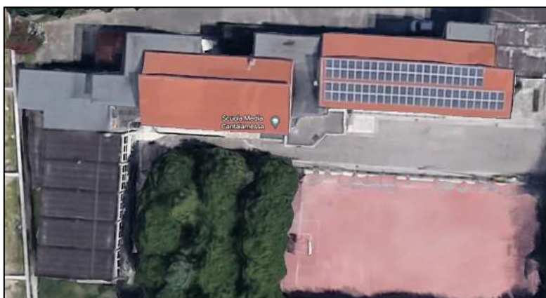
Figura 31: Vista aerea impianto fotovoltaico
