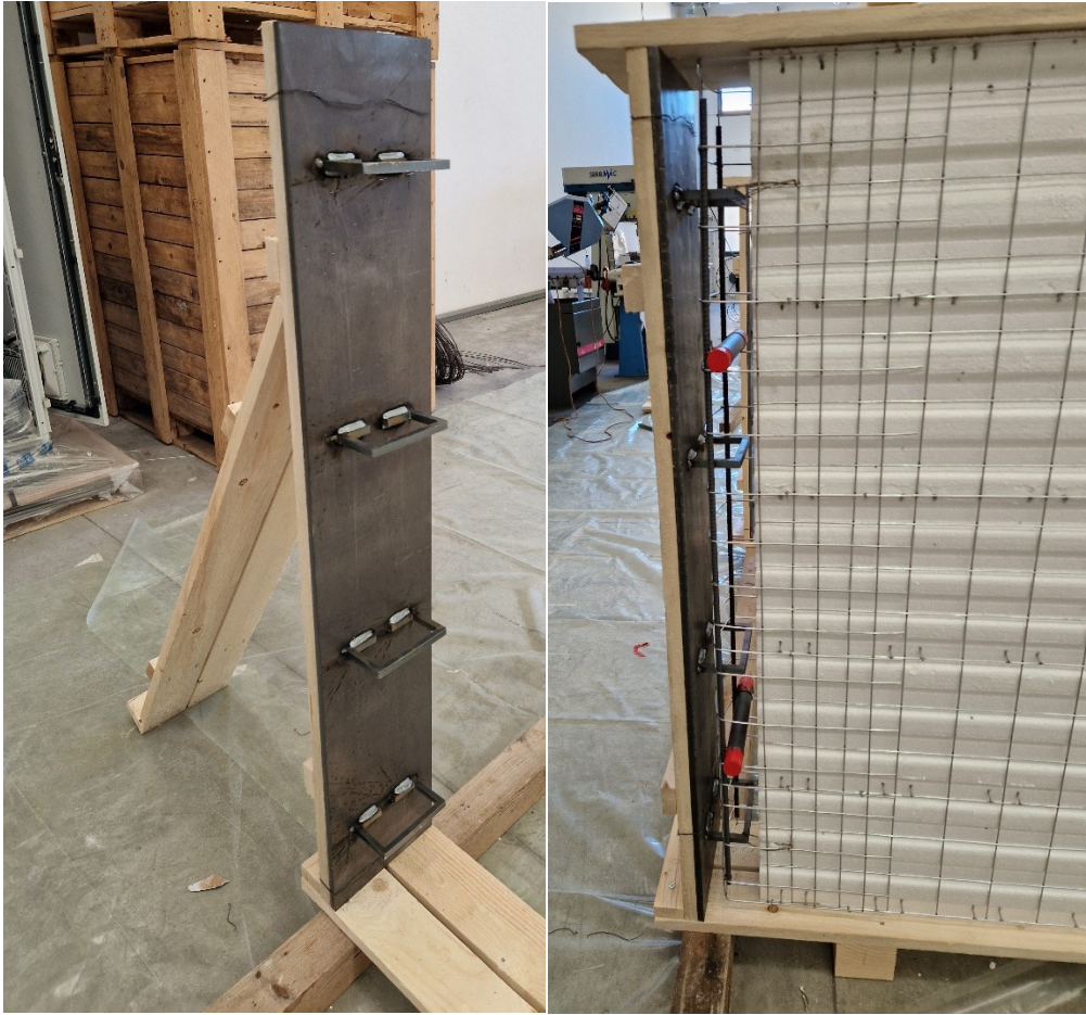
Figura 25 - Armatura dei cordoli
