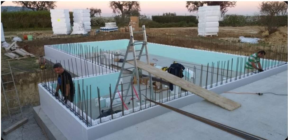
Figura 5 – Piscina realizzata con casseri di polistirolo
