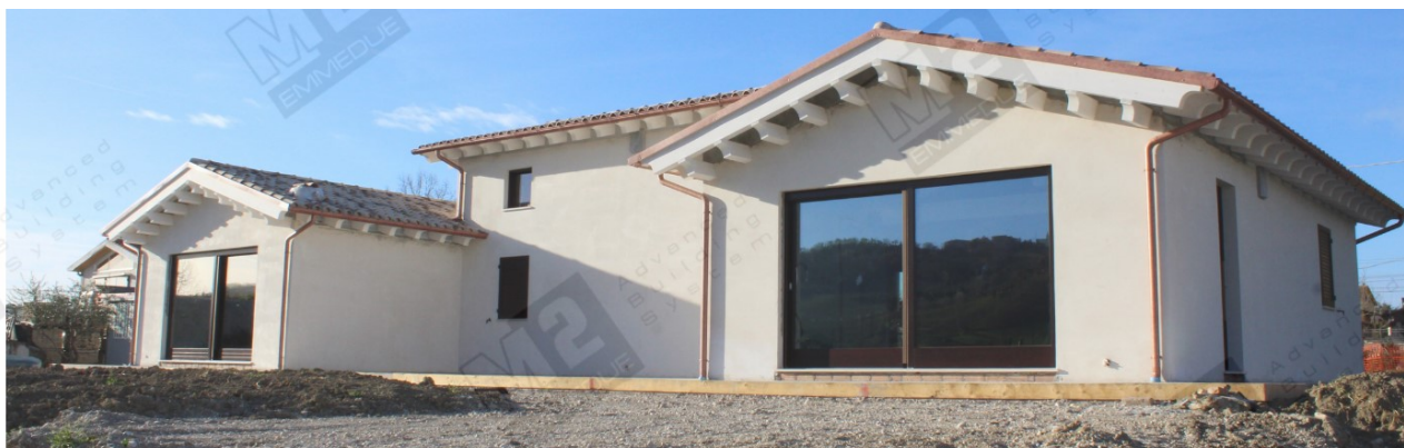
Figura 10 - Esempio di un'abitazione realizzata con pannelli sandwich
