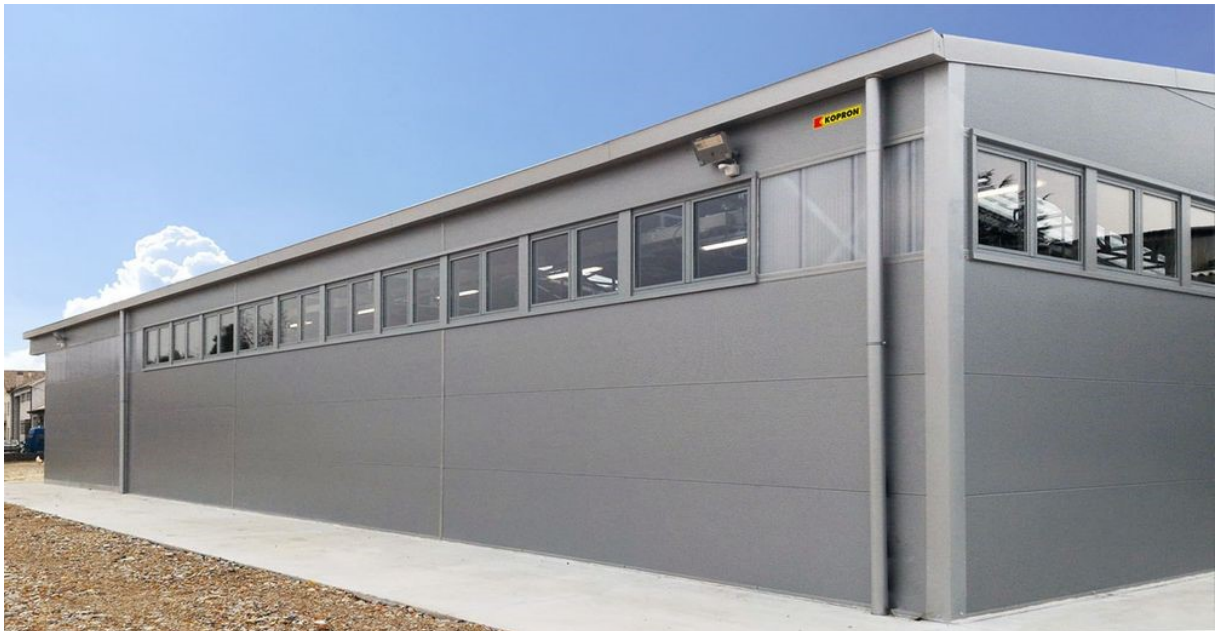
Figura 6 - Capannone realizzato con pannelli sandwich
