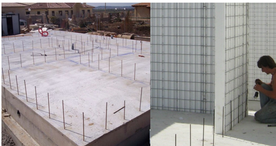
Figura 16 - Ancoraggio alla fondazione
