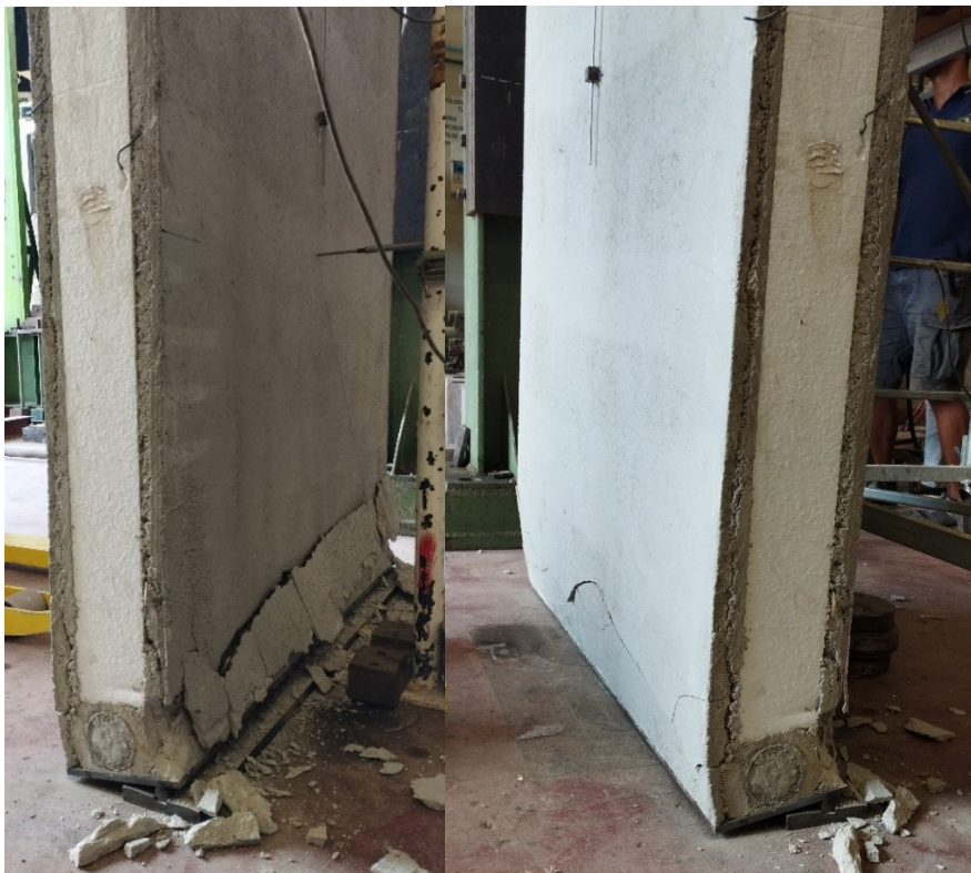
Figura 45 - Rottura per schiacciamento del cordolo inferiore EI
