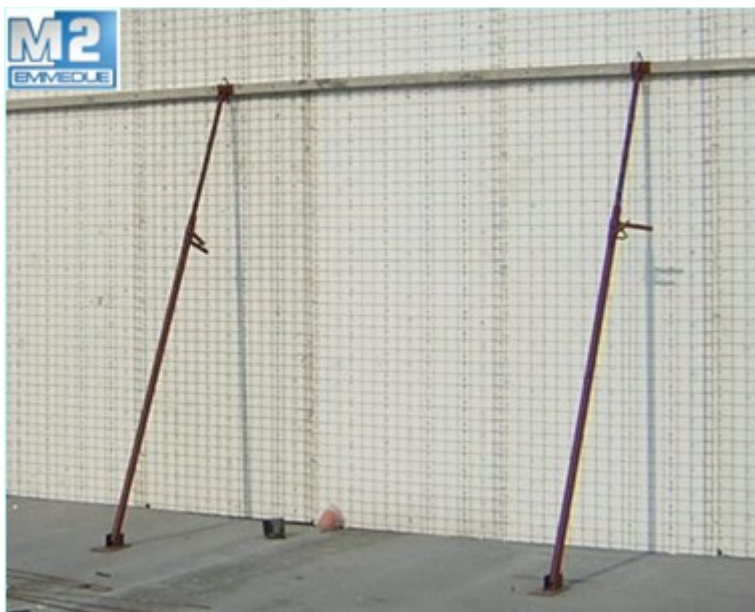
Figura 17 - Disposizione dei puntelli diagonali per la posa in opera dei pannelli
