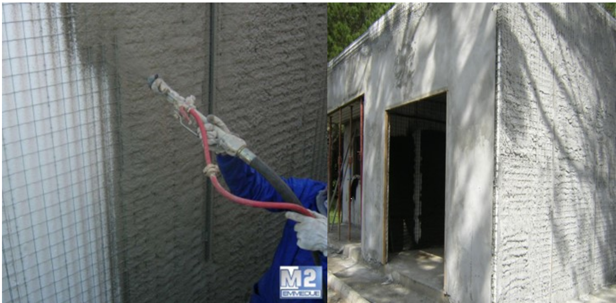
Figura 19 - Getto di completamento dello spritz beton
