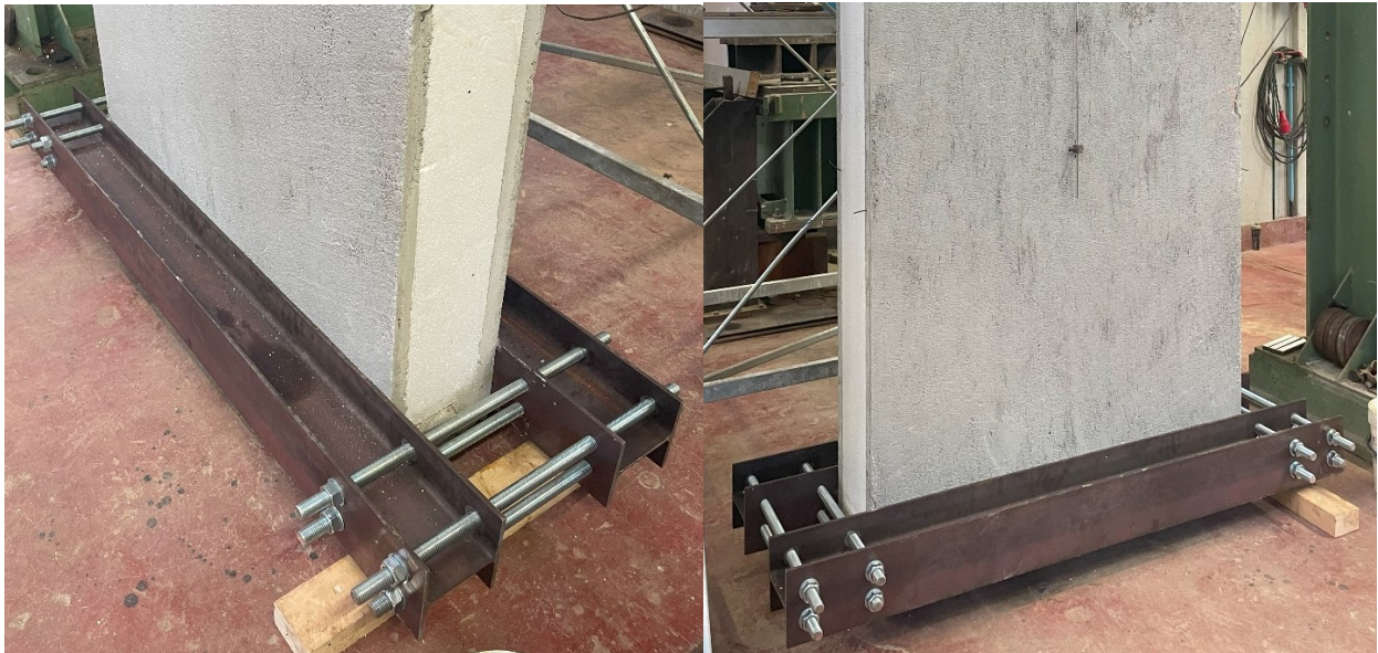
Figura 32 - Profilati metallici in corrispondenza del cordolo inferiore
