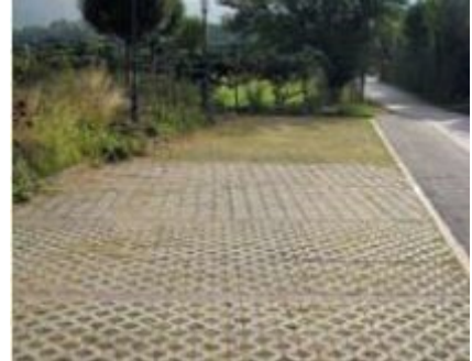
Figura 1.16_Superficie di infiltrazione di tipo pavimentazione permeabile
