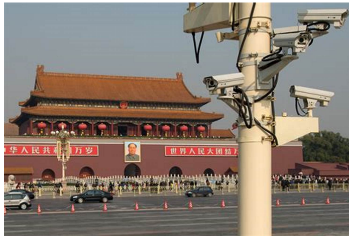
Figura 2.4: Un sistema di sorveglianza installato a Piazza Tienanmen, Cina
