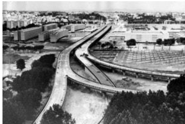
Infrastruttura stradale per le Olimpiadi di Roma, 1960
