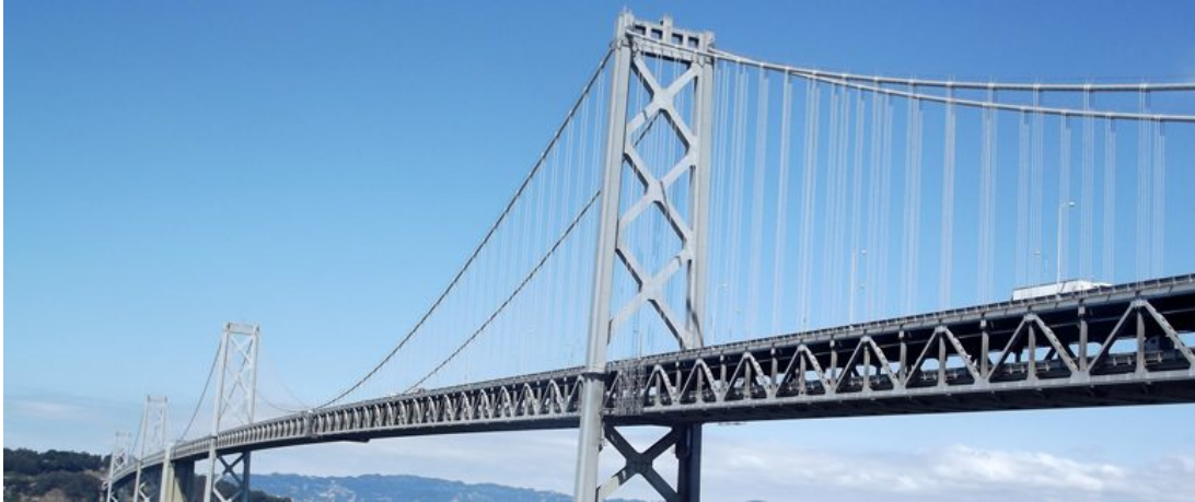
Figura 2.11 Ponte con tiranti in acciaio
