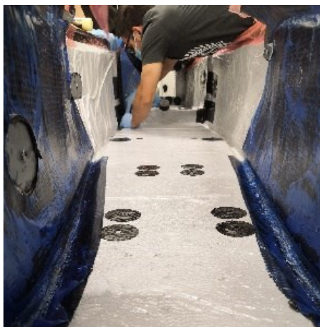
Figura 48 - Patch di rinforzo posizionate in corrispondenza degli inserti
