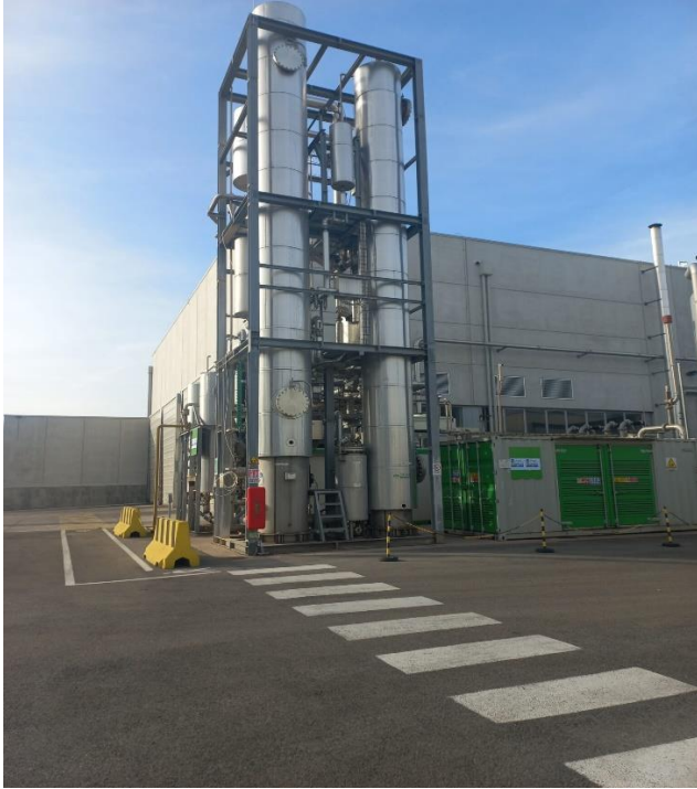
Figura 2: Impianto di digestione anaerobica
