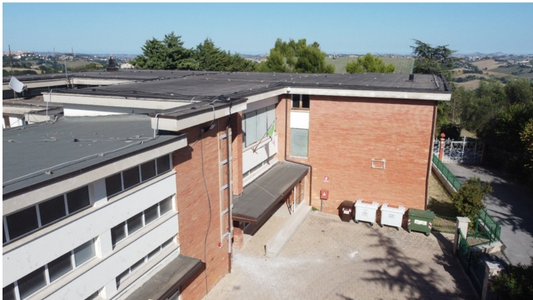
Figura 19: Vista ovest Scuola secondaria Marco Martello
