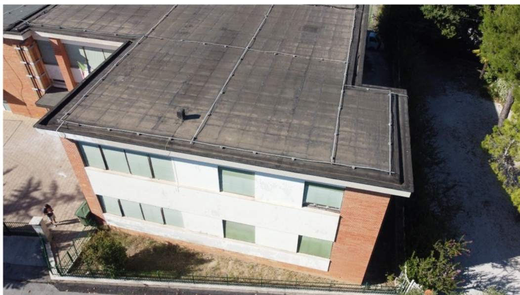
Figura 20: Vista sud Scuola secondaria Marco Martello
