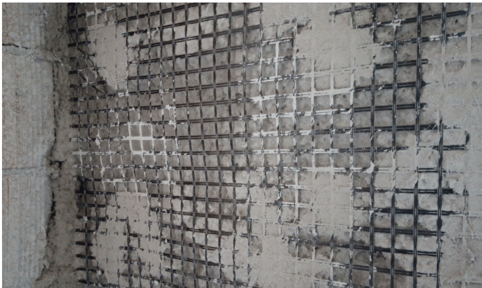
Figura 3.7 Rinforzo strutturale con FRCM
