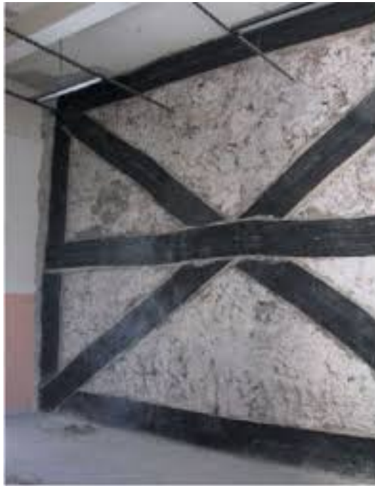
Figura 3.6 Modulo rinforzato con FRP
