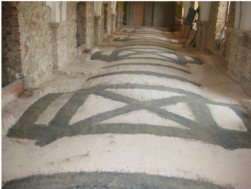
Figura 3.5 Consolidamento strutturale con FRP
