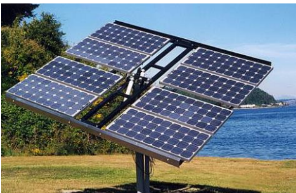
Figura 10: Inseguitore di Azimut [23]
