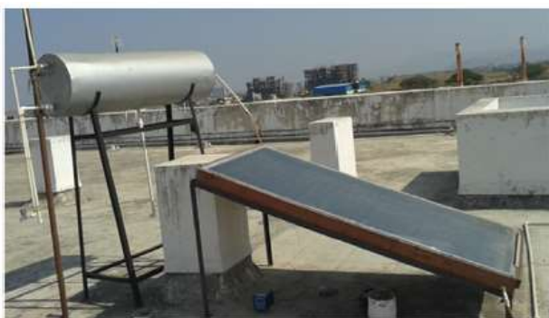
Figura 11 _Scalda acqua solare con collettore in calcestruzzo [20]
