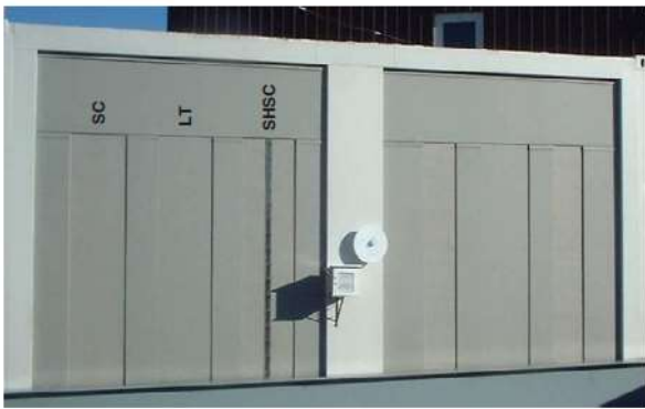
Figura 22 Parete esterna laboratorio solare a Christchurch in Nuova Zelanda [28]
