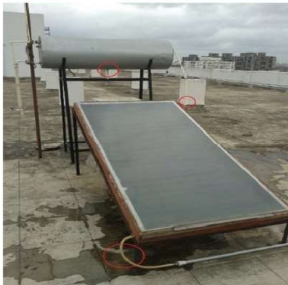
Figura 9_Collettore solare in calcestruzzo [18]
