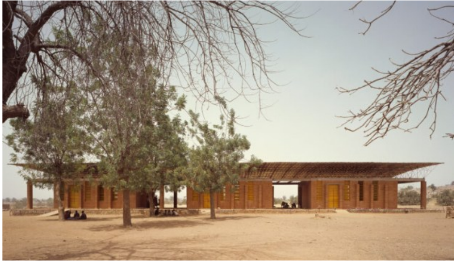
Figura 3-7: La scuola di Gando. (Earth Architecture, 2024)
