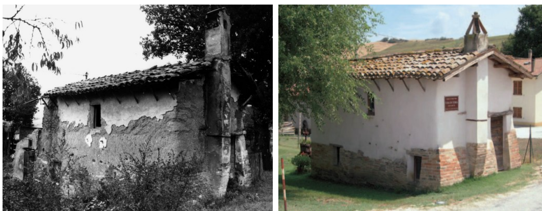
Figura 5-5: Casa Perlini-Santini prima e dopo l'intervento di recupero. (Cesarini, 2005)
