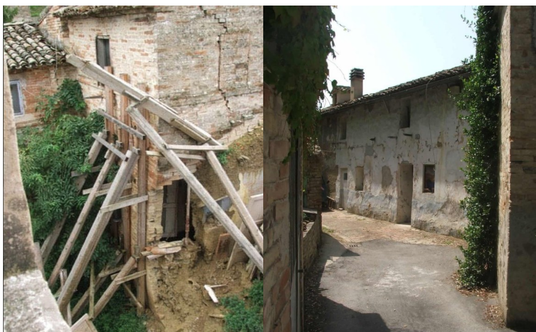
Figura 6-7: Ficana prima del restauro. (Ecomuseo delle Case di Terra Villa Ficana, 2026)
