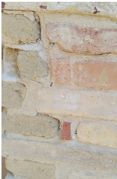
Figura 7-1: Mattoni in adobe integrati con mattoni cotti. (Foto dell'autore)
