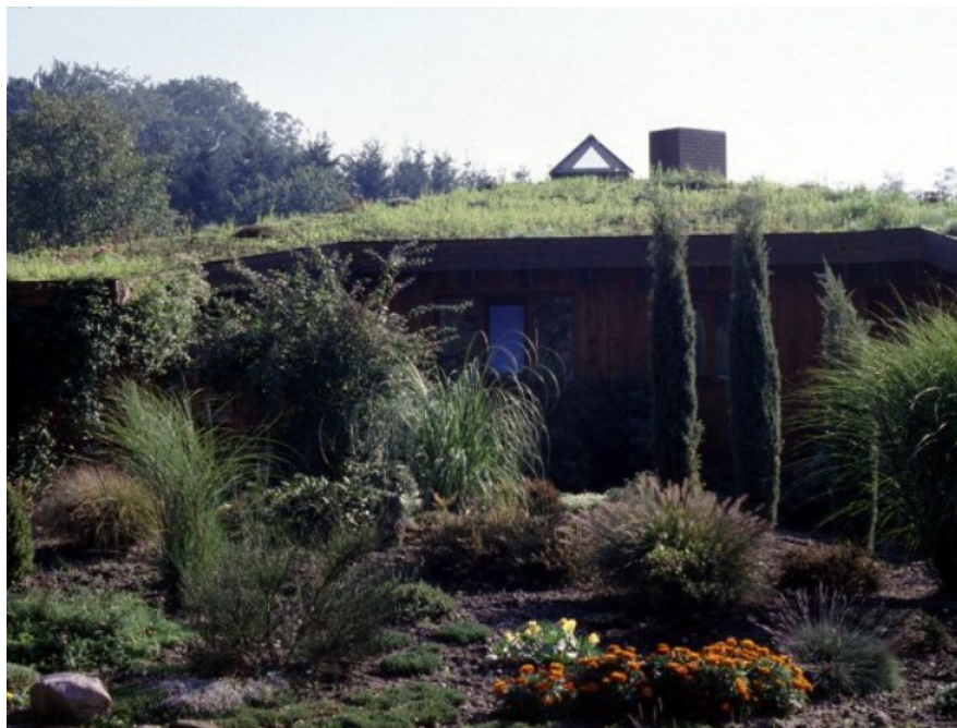
Figura 4-5: Esempio di abitazione in terra in Germania. (Minke, 2026)
