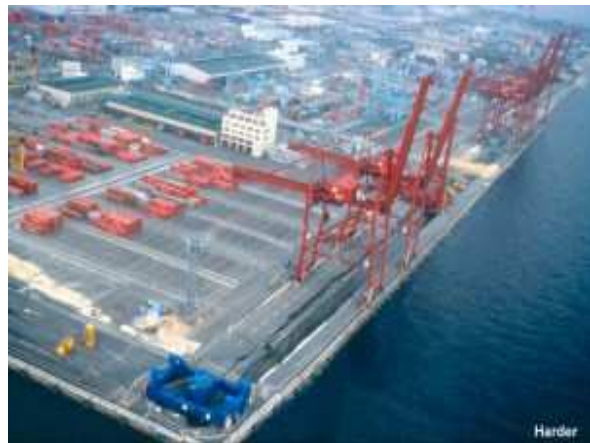
Figura 26: vista aerea del porto di Kobe dopo il terremoto del 1995, nell'angolo in basso a sinistra si nota della sabbia sulla pavimentazione, essa è ribollita in superficie a seguito della liquefazione (immagine presa da UC Davis)
