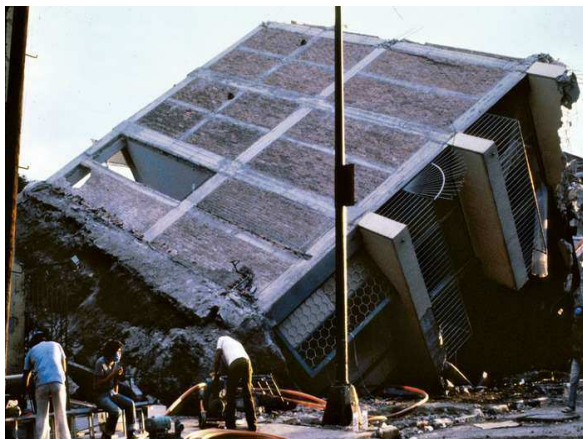
Figura 20: Edificio a otto piani ribaltato e strappato dalle fondazioni, in seguito al terremoto di Città del Messico del 1985 (immagine presa da USGS)
