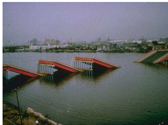
Figura 15: crollo del ponte Showa per via dell'allontanamento reciproco delle campate (immagine presa da National Geophysical Data Center)
