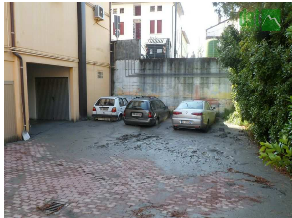
Figura 37: sabbia e limo che risalgono in superficie su un pavimentazione privata, in seguito al terremoto che colpì l'Emilia nel Maggio 2012 (immagine presa da www.bresciatoday.it )
