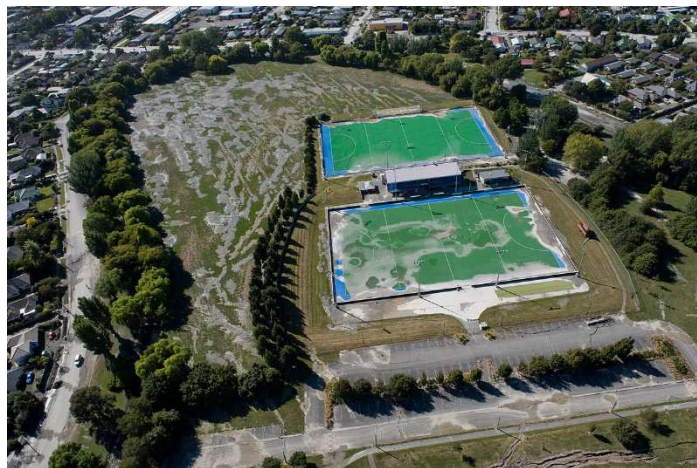
Figura 34: effetti della liquefazione estesi a tutta la città di Christchurch, a seguito degli omonimi terremoti verificatisi tra il 2010 e il 2011 (immagine presa da wikipedia.org)
