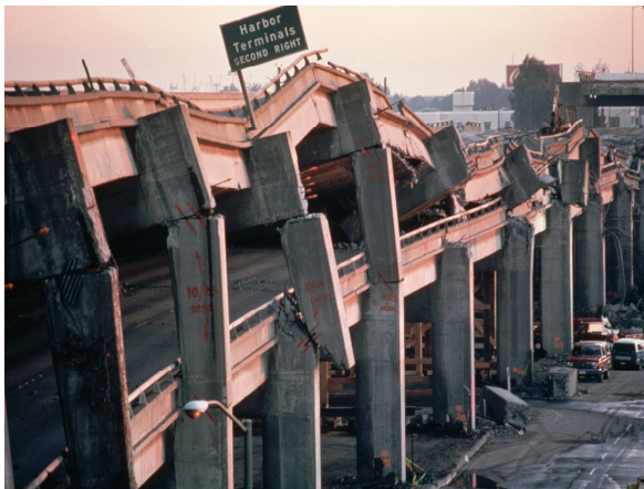
Figura 23: foto del viadotto a due livelli di Cypress Street, dove il piano superiore è collassato su quello inferiore e i pilastri hanno ceduto, a seguito del terremoto che colpì San Francisco nel 1989 (immagine presa da history.com)
