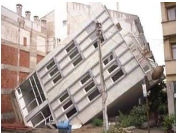
Figura 28: un edificio crollato per via della liquefazione del suolo, a seguito del terremoto di İzmit nel 1999 (immagine presa da researchgate.net)
