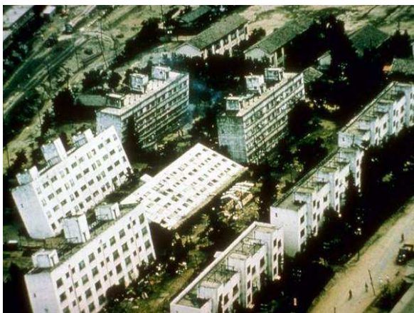
Figura 14: Veduta aerea di case a schiera inclinate a Niigata, prodotte dalla liquefazione del suolo (immagine presa da National Geophysical Data Center)
