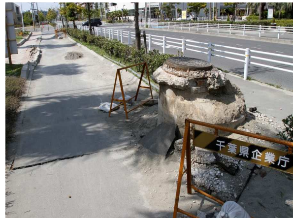
Figura 32: effetti della liquefazione in Urayasu, a seguito del terremoto di Tōhoku nel 2011 (immagine presa da tokyoreporter.com)
