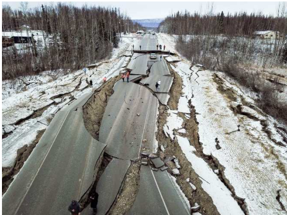
Figura 11: Danni ingenti ad una strada a seguito di una frana in Alaska, dopo il terremoto del 1964 (immagine presa da Anchorage Daily News)
