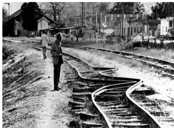
Figura 18: Danni alla linea ferroviaria dopo il terremoto di Tangshan del 1976 (immagine presa da Ocio Magazine)
