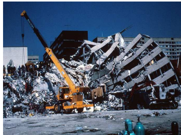
Figura 21: Nuevo León, complesso di appartamenti crollato per una parte mentre l'altra è rimasta poco danneggiata, in seguito al terremoto di Città del Messico del 1985 (immagine presa da USGS)
