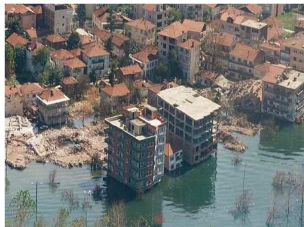
Figura 29: zona abitativa che ha subito un inondazione, a seguito del terremoto di İzmit nel 1999 (immagine presa da karar.com)
