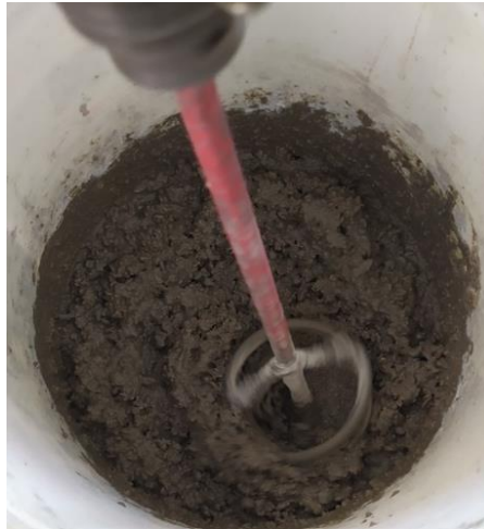
Figura 21 Miscelazione della malta per sottofondi.
