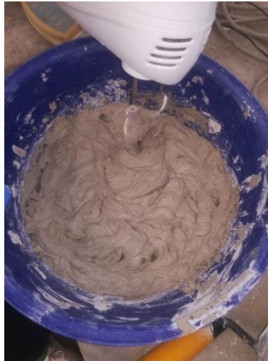
Figura 17 Processo di miscelazione della malta con l'utilizzo di un mixer.
