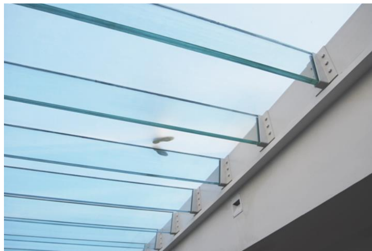
Figura 1 - Pavimento in vetro strutturale
