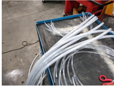
Preparazione sul carrello delle tubazioni
