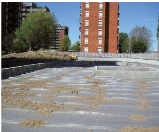
Fig. 30 Posa in opera orizzontale
