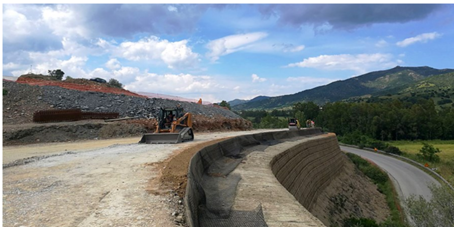
Fig. 41 Utilizzo terre rinforzate S.S. 125 "Orientale Sarda"
