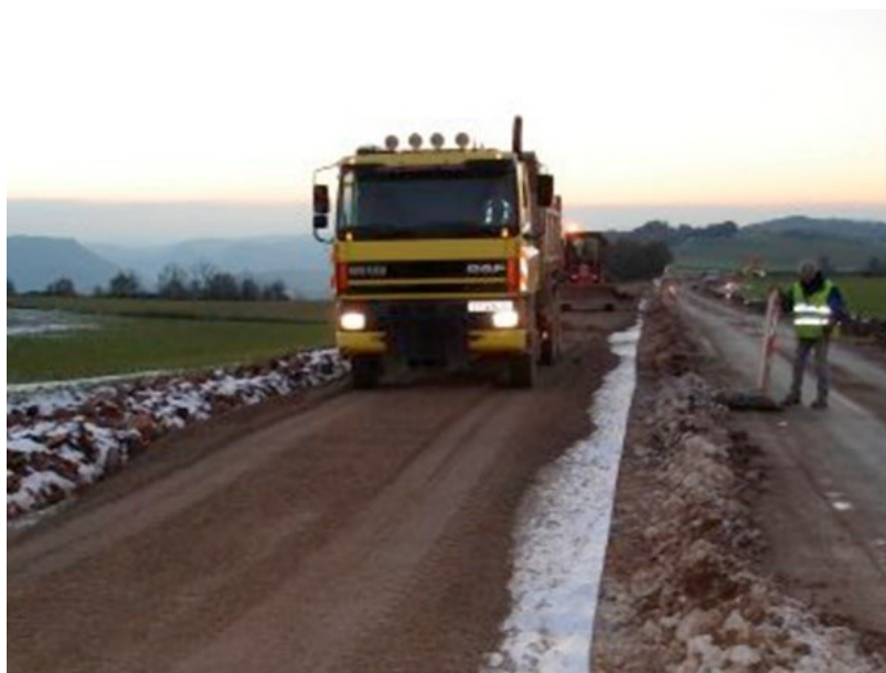
Fig. 28 Posa in opera di geocompositi drenanti
