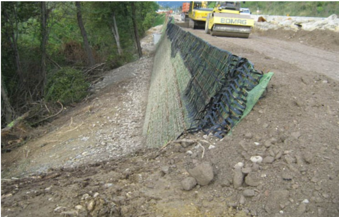
Fig. 32 Terre armate per realizzazione stradale
