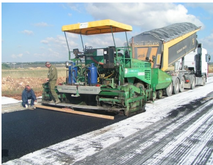
Fig. 18 Utilizzo dei geotessili nelle costruzioni stradali
