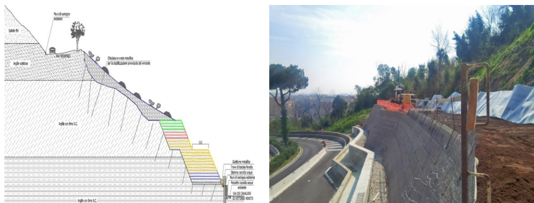
Fig. 42 Sistemazioni dei versanti con terre rinforzate
