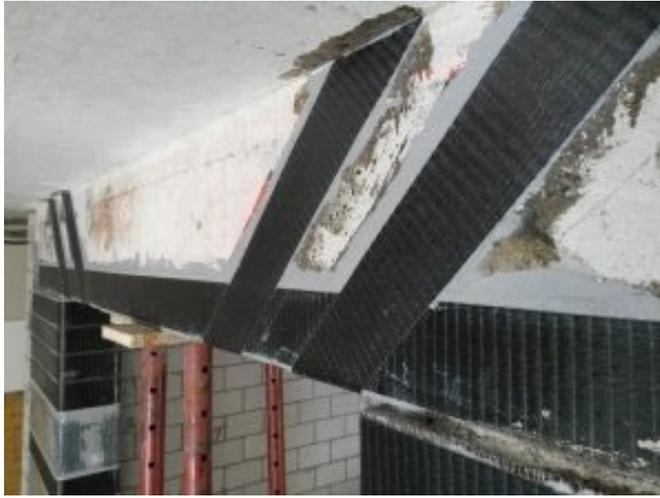
Figura 2.3. Esempio di posa in opera di CFRP ancora a “grezzo”.
