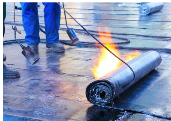
Figura 3. (a) applicazione membrana autoadesiva, (b) applicazione membrana a fiamma
