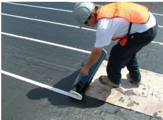
Figura 3. (a) applicazione membrana autoadesiva, (b) applicazione membrana a fiamma
