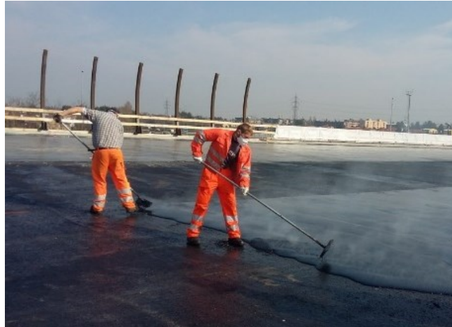
Figura 4. Applicazione del sistema realizzato in opera
