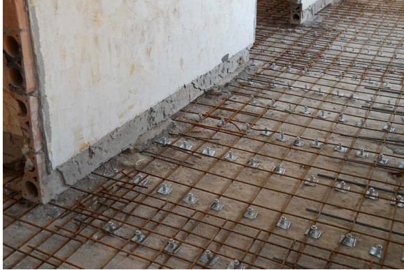
(a) Realizzazione di una soletta collaborante
