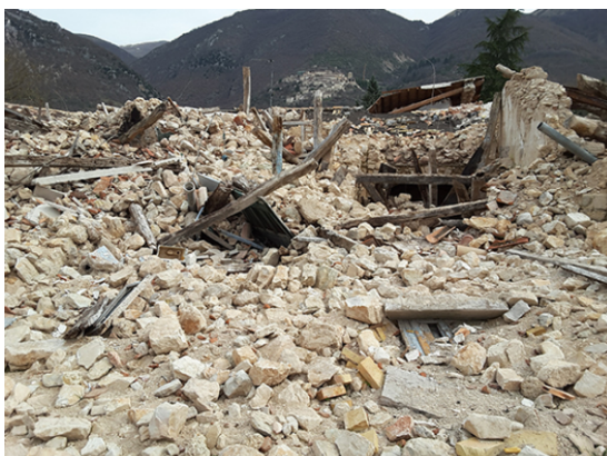
(a) Caso di disgregazione murara, causato da muratura scadente
