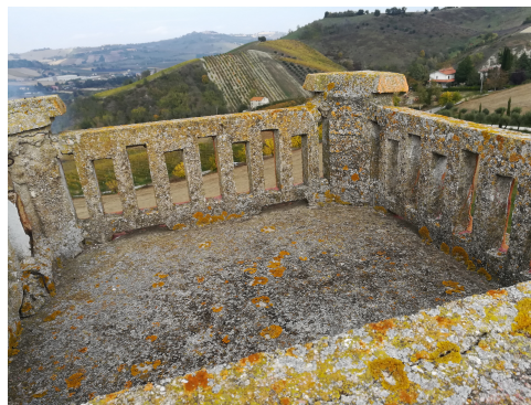
(b) Soletta di copertura e piccolo parapetto ornamentale
