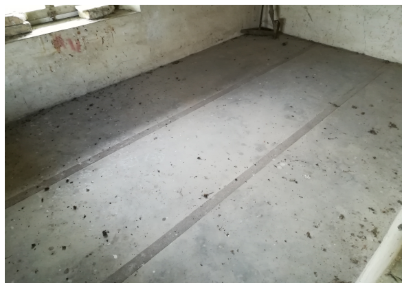
(a) Estradosso solaio con putrelle a vista
