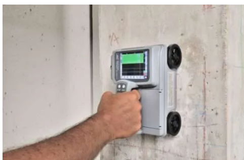
Figura 1.30: Esecuzione di una prova radar su muratura
