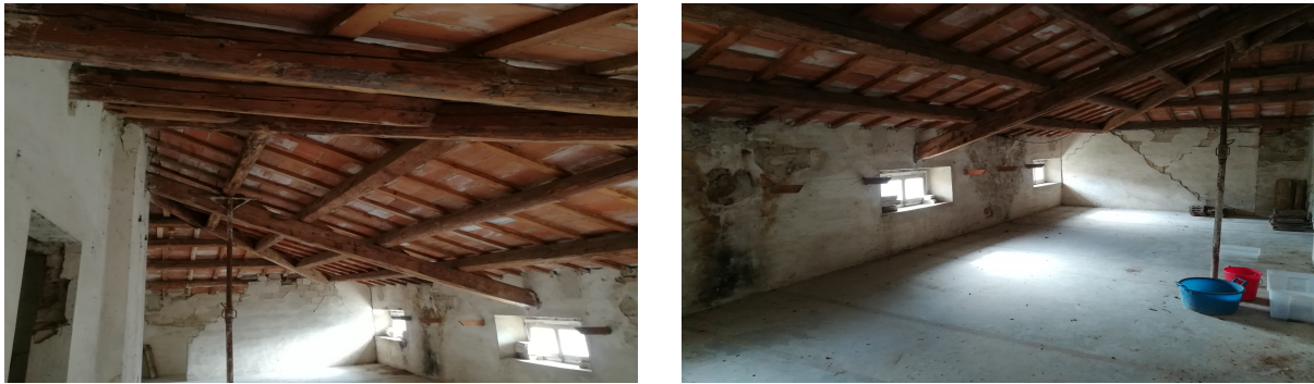
Figura 2.7: Intradosso del solaio di copertura: sono visibili le 3 orditure e i tavelloni in laterizio.
