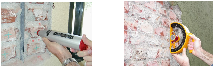
Figura 1.26: Prova sclerometrica sui laterizi e sui giunti di malta.
