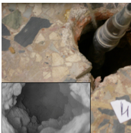
Figura 1.28: Diagnostica di un elemento strutturale con endoscopio.
