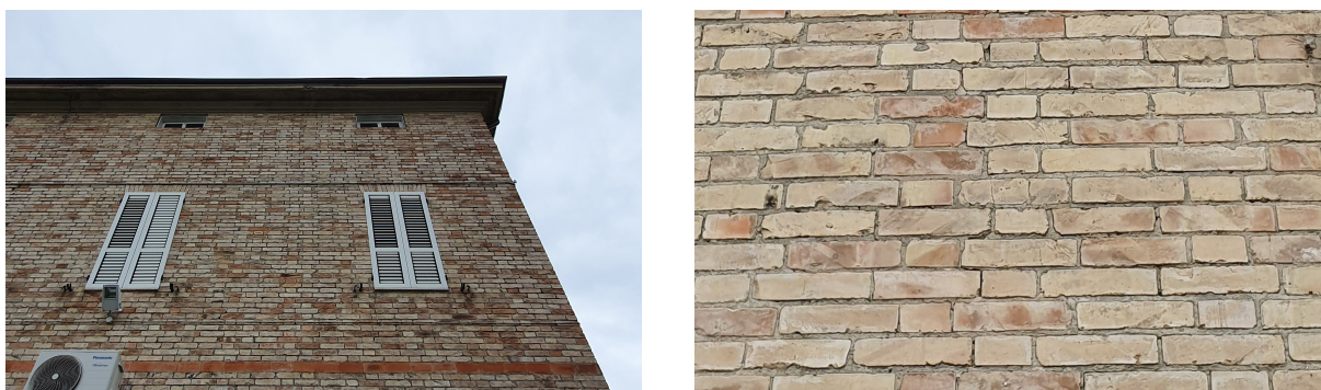
Figura 2.27: Dettagli della muratura perimetrale.
