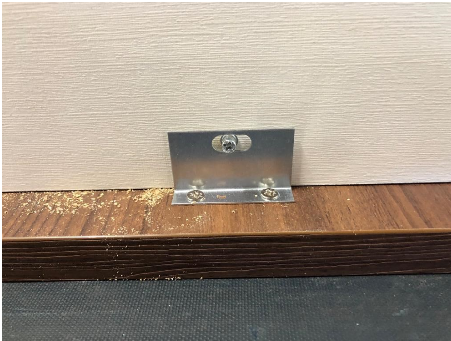
Figura 58: Focus della piastrina e delle viti sul cestone
