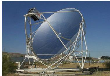
Figura 1.27: Collettore a disco parabolico [53]
