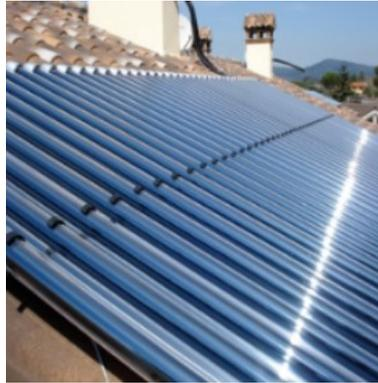
Figura 1.26: Collettore a tubi sottovuoto [52]
