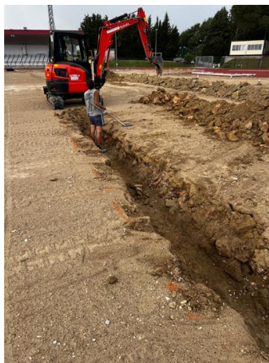
Figura 32. Scavo per posizionare le tubazioni per il futuro sistema di drenaggio
