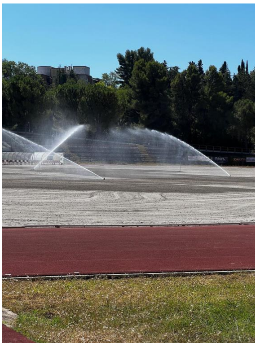
Figura 36. Prima accensione del nuovo impianto d'irrigazione datato 12 luglio
