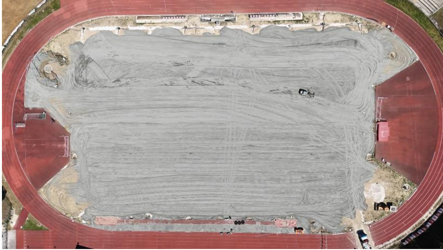
Figura 35. Spandimento di sabbia silicea
