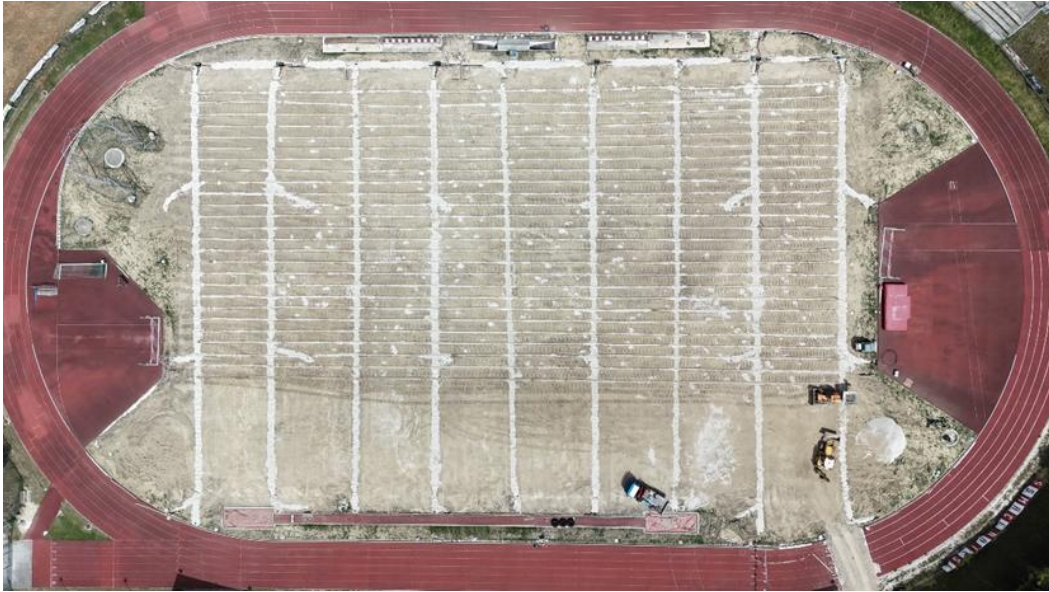
Figura 31. Segnatura delle linee di drenaggio
