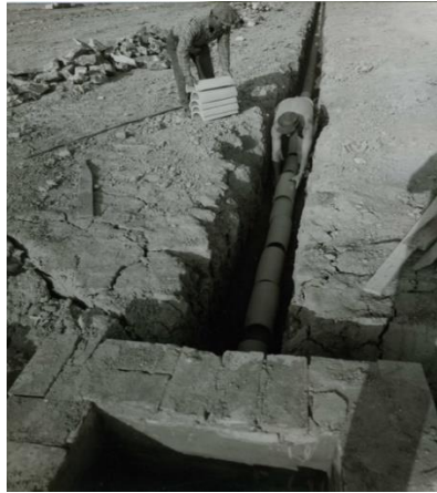
Figura 25. Applicazione delle "canale"
