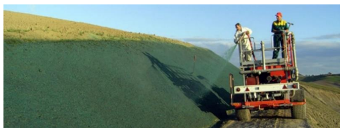
Figura 8. Realizzazione dell'idrosemina
