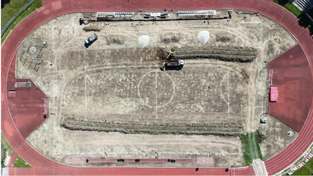
Figura 29. Scarificazione
