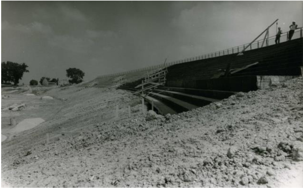
Figura 23. Prime fasi di realizzazione della tribuna risalenti agli anni 60'
