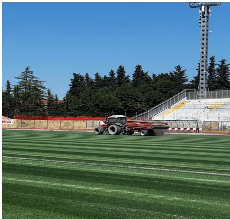
Figura 38. Spandimento sabbia sui rotoli
