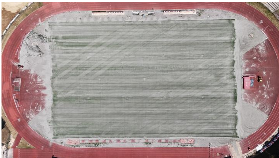
Figura 37. Foto aerea sabbiatura
