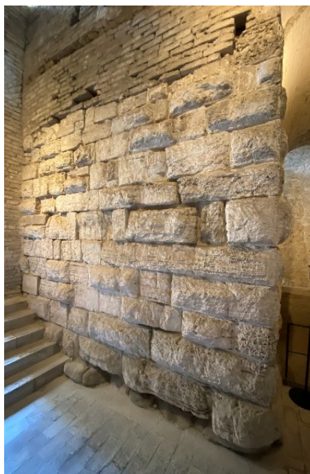
Figura 2.60 – Il basamento della torre in grossi blocchi calcarei rettangolari bugnati
