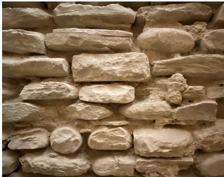
Figura 3.11 – Conci sbozzati di spessore diverso presenti al piano interrato della torre della Rocca Roveresca.
