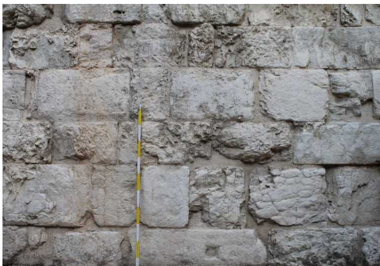
Figura 3.9 – Blocchi lapidei squadrati in corrispondenza del macroelemento torre (TR) visibili sul lato nord est del cortile della Rocca Roveresca.
