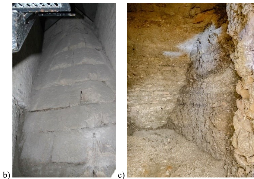
Figura 2.70 – Scarpa muraria Malatestiana osservabile in corrispondenza: a) del piano terra, nel corridoio a sx dell'ingresso principale; b) del torrione ovest; c) del piano interrato, all'interno di una breccia ricavata nell'antica muratura (si osserva l'inclinazione della muratura sullo sfondo).
