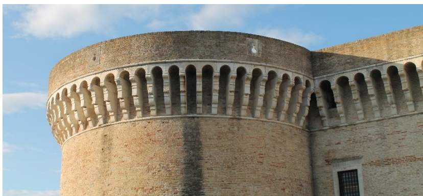
Figura 2.78 – Il coronamento in beccatelli litici di pietra bianca d'Istria.
