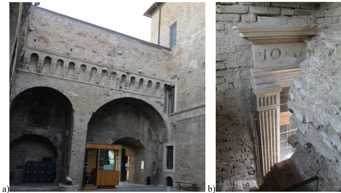
Figura 2.82 – L'ultimo intervento subito dalla Rocca Roveresca. a) ampliamento visto dal cortile interno; b) particolare dell'addossamento murario alla finestra rinascimentale.
