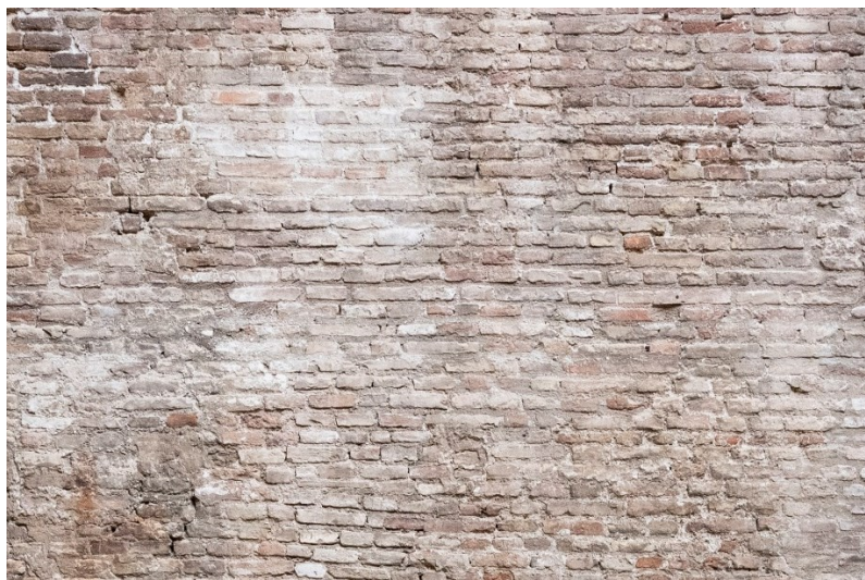
Figura 3.8 – Muratura in mattoni pieni nel lato nord ovest del cortile della Rocca Roveresca.
