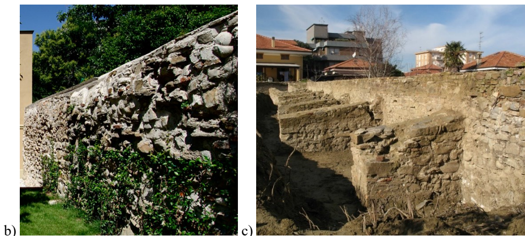
Figure 2.37 – a) Baluardo del porto, b) Foto abitazione privata in via Narente. Fonte [33]; c) testimonianza dei contrafforti nel baluardo del Porto scoperti in seguito ai lavori per realizzazione di un nuovo edificio residenziale in via Rodi – Senigallia. Fonte [34].
