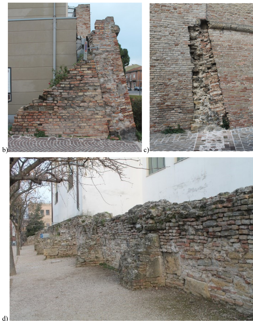
Figure 2.35 - a) Foto agosto 1990 - Veduta dei setti interni delle mura Roveresche (cd. bastione di San Martino) del Teatro "la Fenice" (foto Soprintendenza per i Beni Archeologici delle Marche); b) Teatro "la Fenice", via C. Pisacane; c) Porta Lambertina, via G. Carducci; d) Scuola elementare G. Pascoli, Via G. Oberdan.
