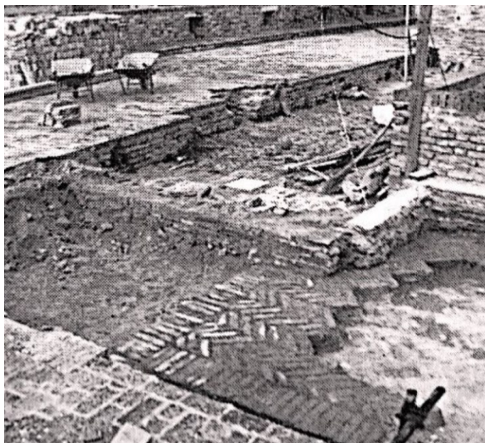
Figura 2.87 – Restauro della pavimentazione del terrazzo di copertura e ritrovamento delle pavimentazioni originarie. Archivio lavori soprintendenza. Perizia n. 578 del 24-09-1971 [38].
