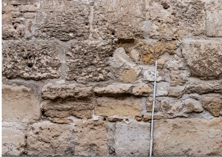
Figura 3.10 – Pietre a spacco presenti nel lato nord ovest del cortile della Rocca Roveresca.
