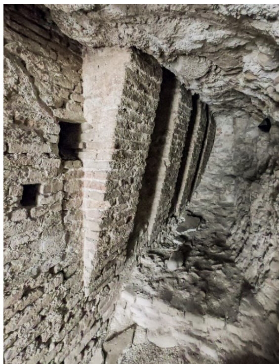
Figura 2.65 – Apparato a sporgere rintracciabile nella parte interna SO della Rocca, al di sopra dell'ingresso.
