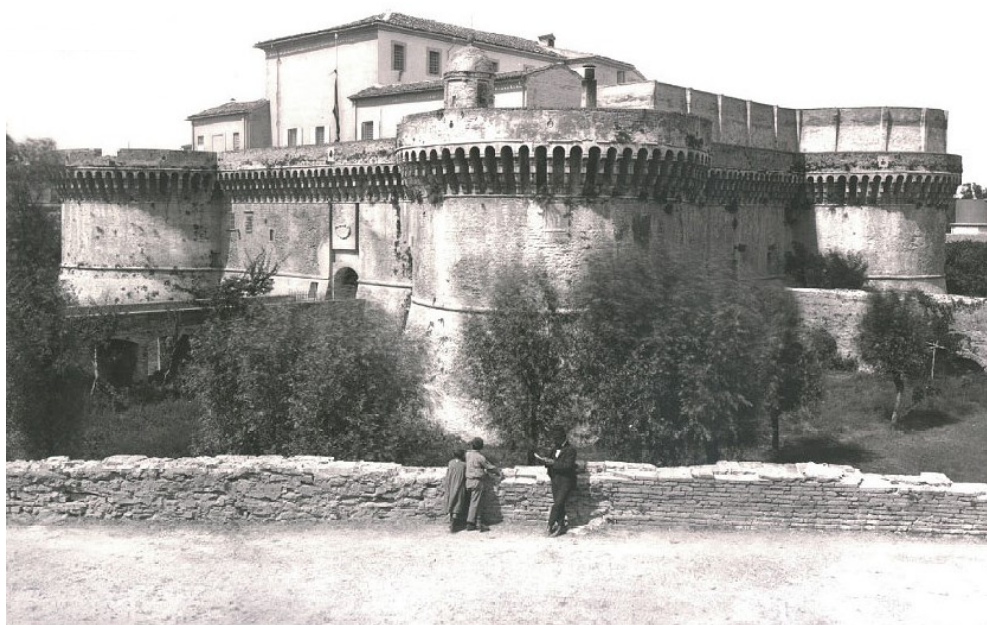
Figura 2.86 – Veduta esterna databile agli anni 1915-20: sono visibili sulla copertura costruzioni varie e sopraelevazioni connesse all'uso a carcere, una garitta per uso militare e l'utilizzazione a vivaio e giardino del vallato, con accesso dal ponte levatoio. Archivio fotografico Alinari – Firenze [11].
