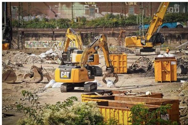
*Figura 6.5.1. Esempio di demolizione selettiva (Fonte <http://www.recoverweb.it/>)*
