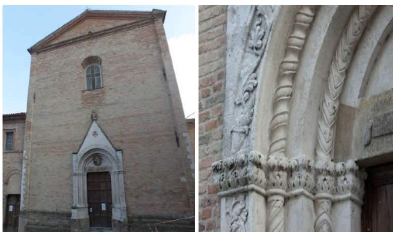
Figura 3.3.3. Facciata e particolare del portale di San Francesco di Amandola (Fonte: www.luoghidelsilenzio.it ).
