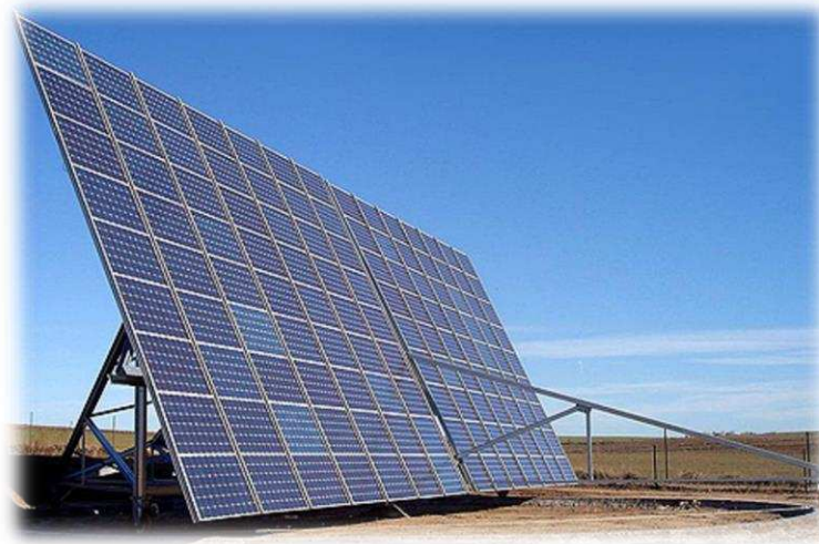
Figura 20: Inseguitore di azimut-elevazione [24].
