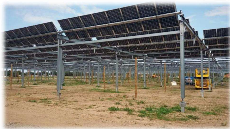
Figura 17: Inseguitore di rollio [21].
