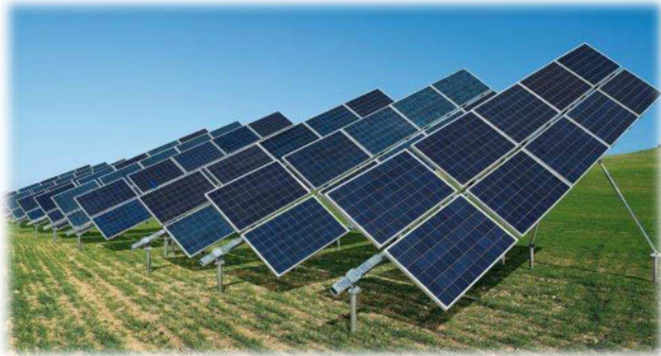
Figura 19: Inseguitori ad asse polare [23].
