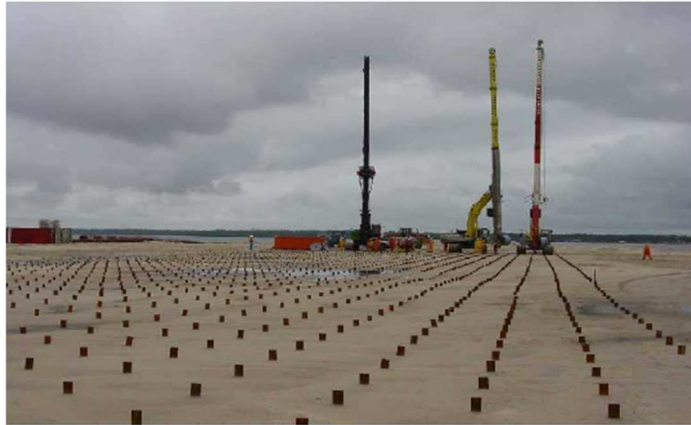
Figura 1.2 - Installazione dreni prefabbricati
