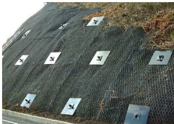
Figura 1.12 - Esempio di tiranti di ancoraggio
