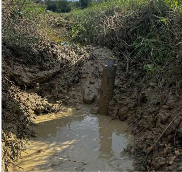
Figura 79 Scavo per liberare il sensore
