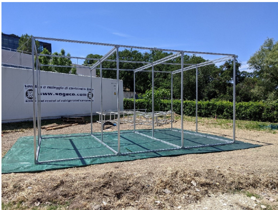
Fig. 17 – Foto della struttura
