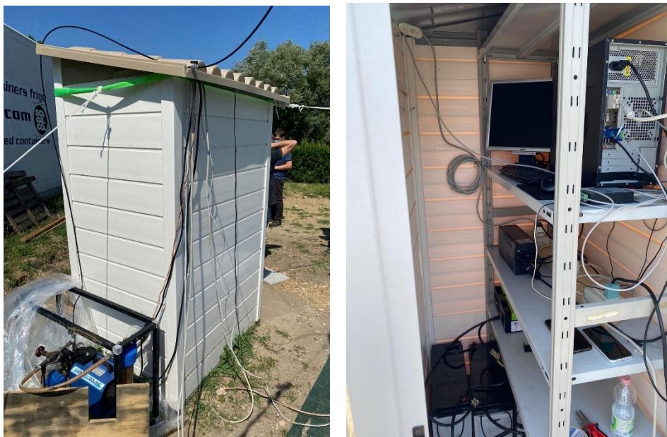
Figg. 52 e 53 – Casetta visione esterna e interna
