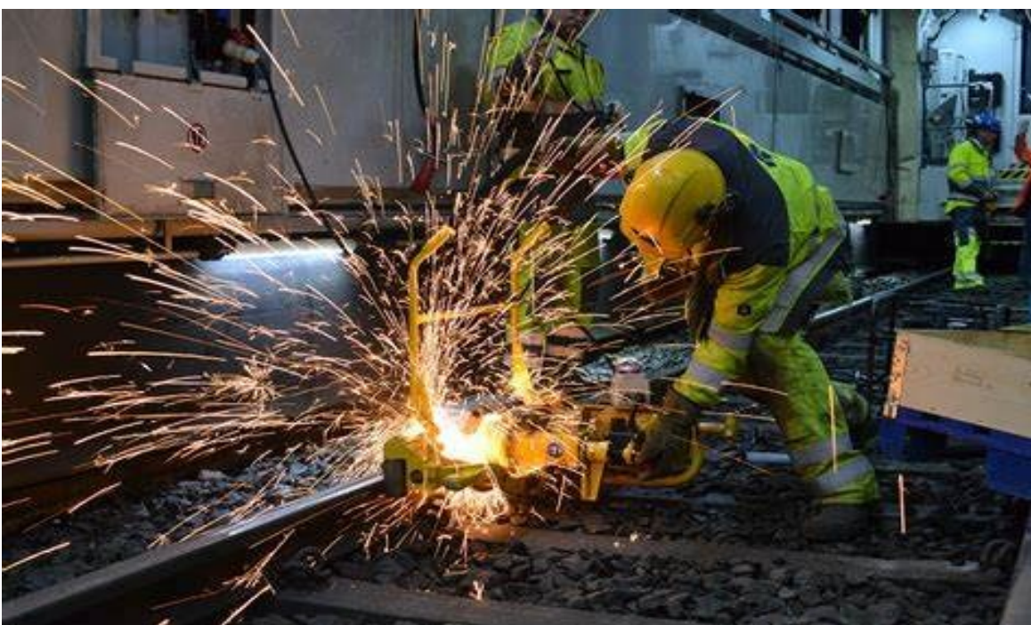
Taglio della rotaia da parte di un operatore dell'unità manutentiva. Fig.24
