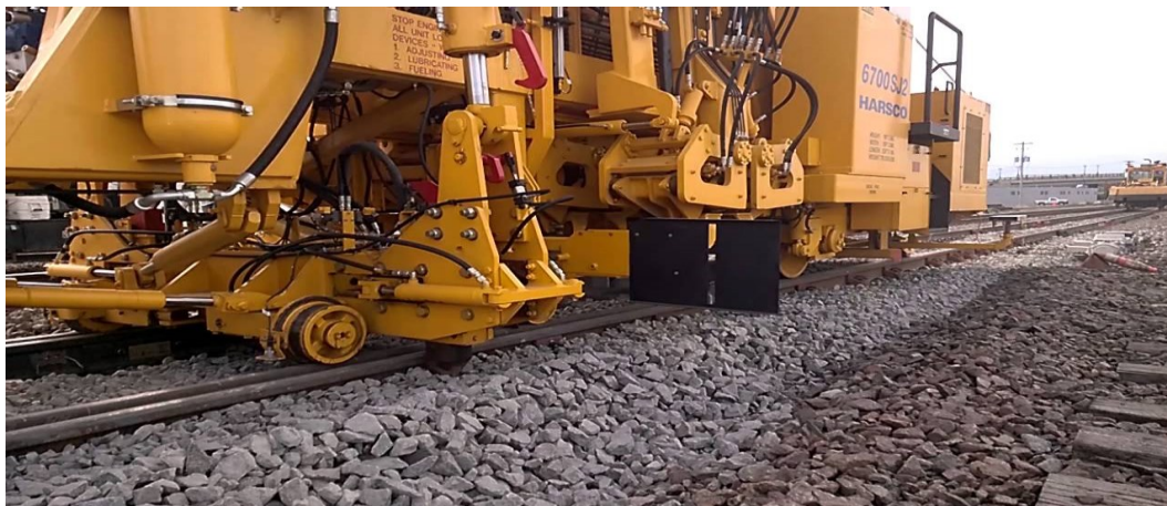
Rincalzatrice in servizio sul binario. Fig.25
