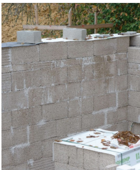
Figura 1-23: blocchi di canapulo e calce (da Ranalli, 2020)
