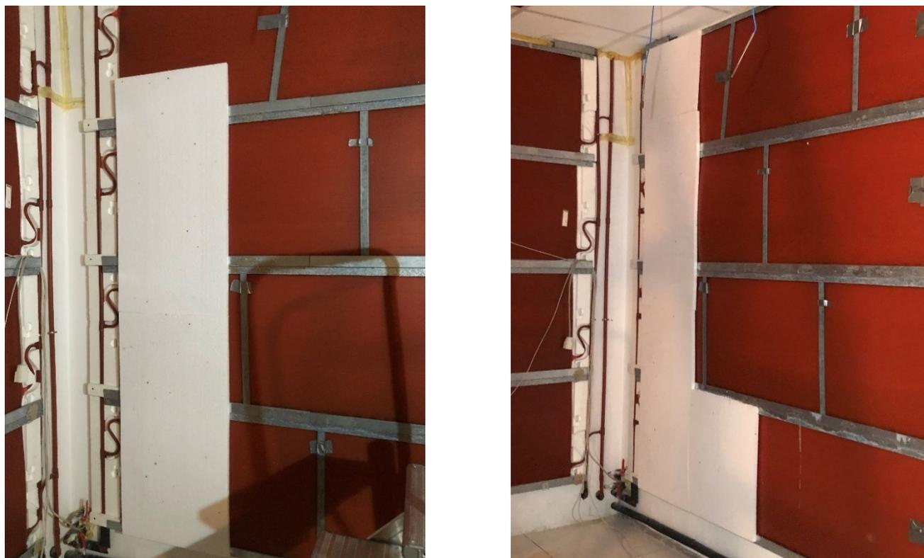
Fig.9. Foto allestimento parete lunga Test-Room con pannelli in polistirene espanso.
