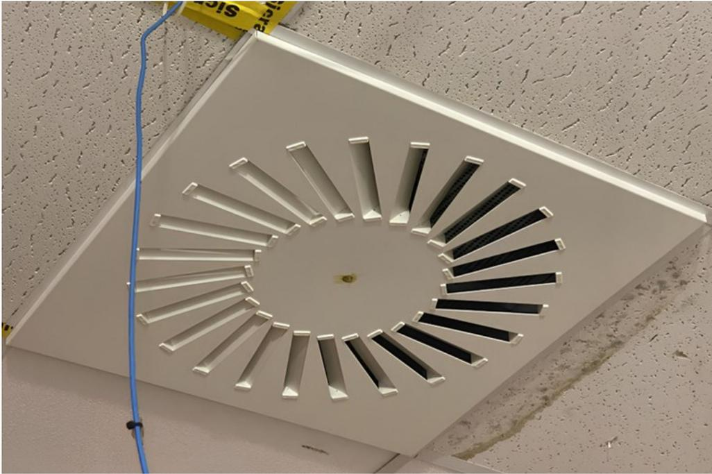
Fig.11. *Diffusore elicoidale per la mandata d'aria.*
