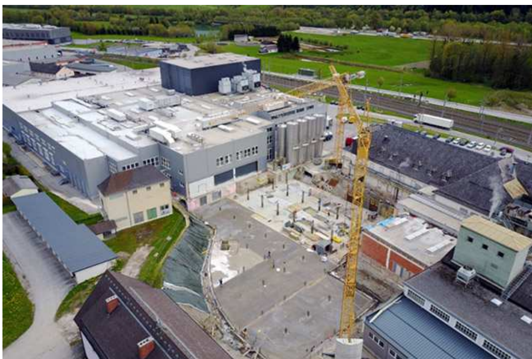
Figura 32 - Milestone di cantiere
