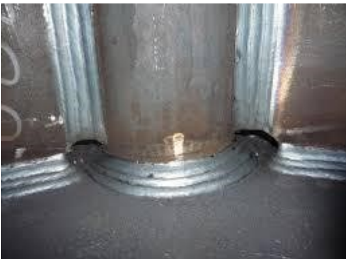
Figura 1.12 (Saldatura a cordone d'angolo nella realtà): in questa immagine si vede la rappresentazione di un saldatura a cordone d'angolo nella realtà.
