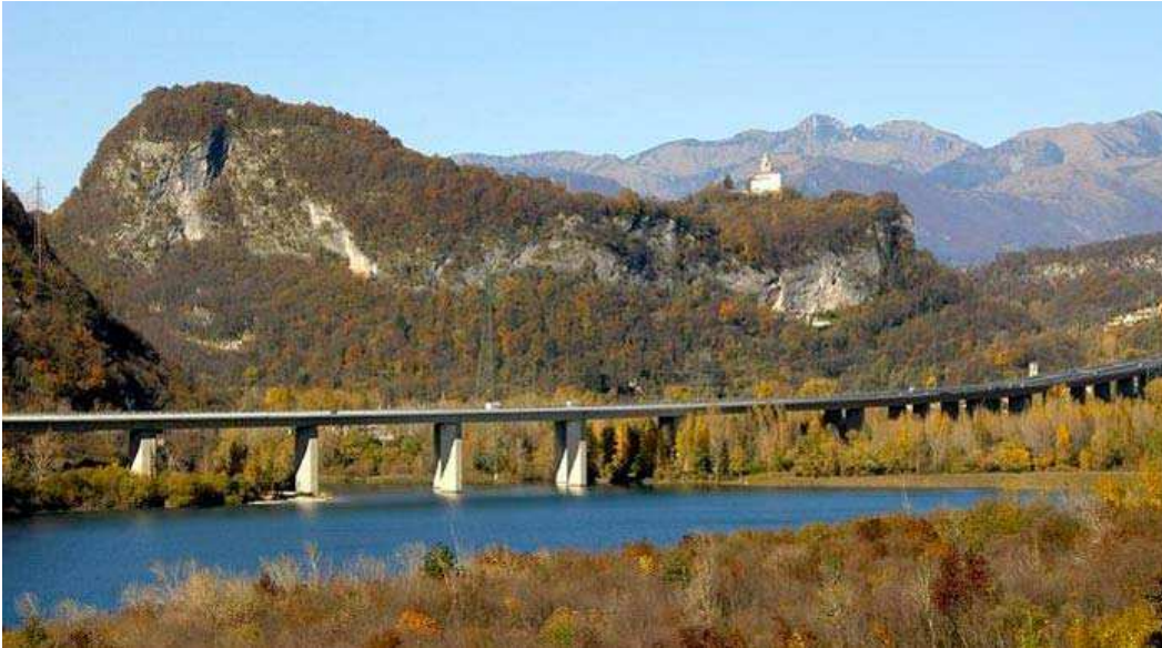
Fig. 78: Foto del viadotto Somplago (Fonte: "ingegno-web.it")
