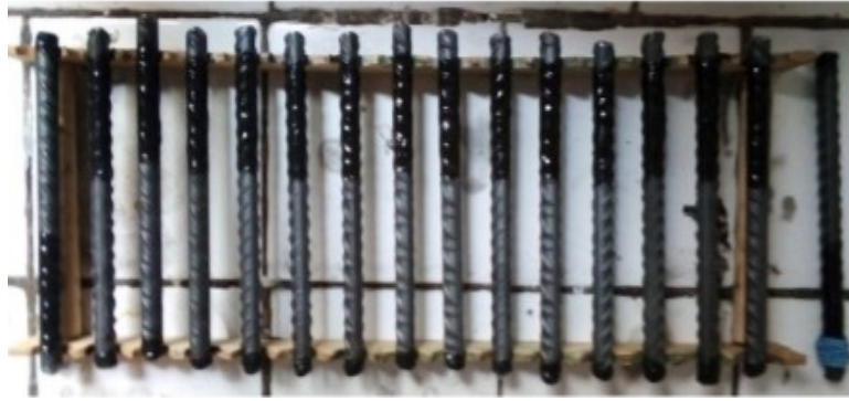
Fig.5.2.5: Barre dopo la resinatura
