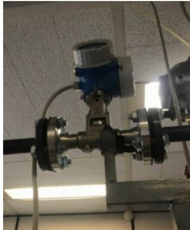
Figura 3.5: Sensore Portata LN3
