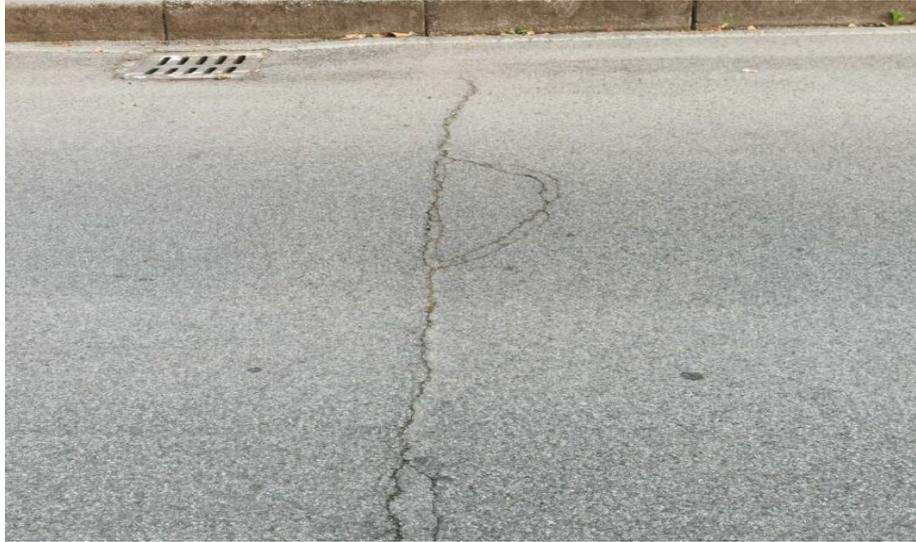
*Figura 0.4 – Fessurazione termica*
