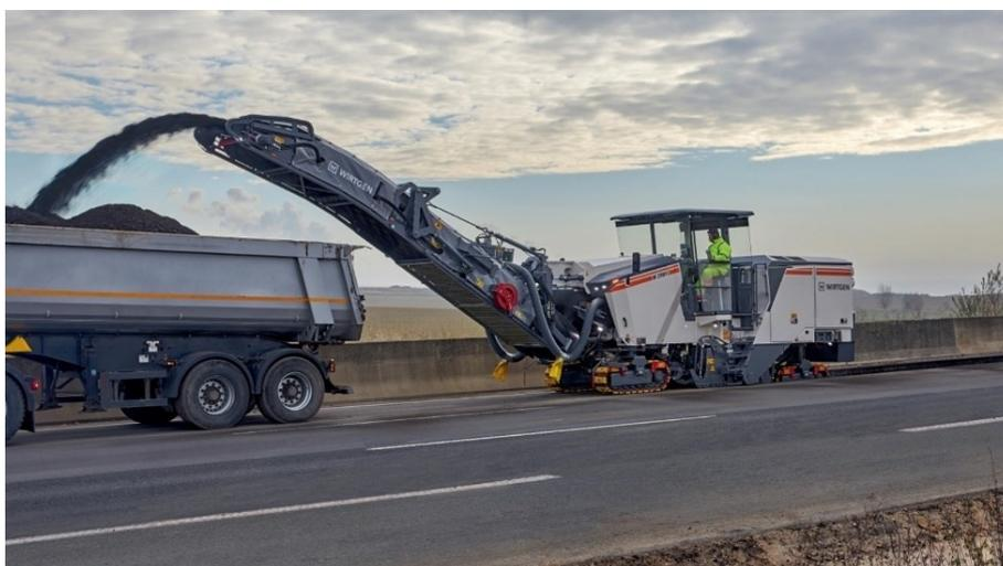
*Figura 0.5 - Fresatura a freddo*
