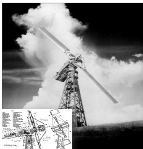
Figura 6.3 Primo aerogeneratore Multi-megawatt
