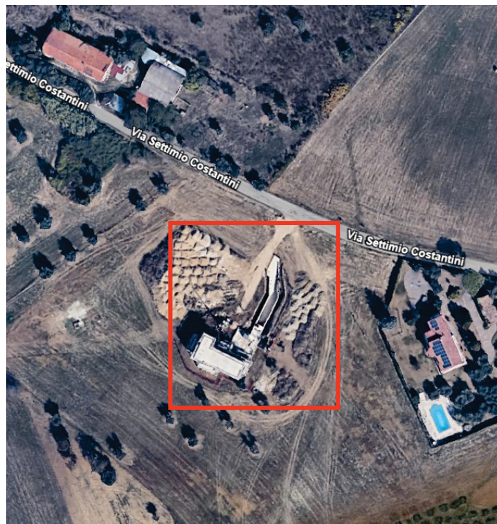
Figura 1: Vista satellitare dell'edificio in costruzione
