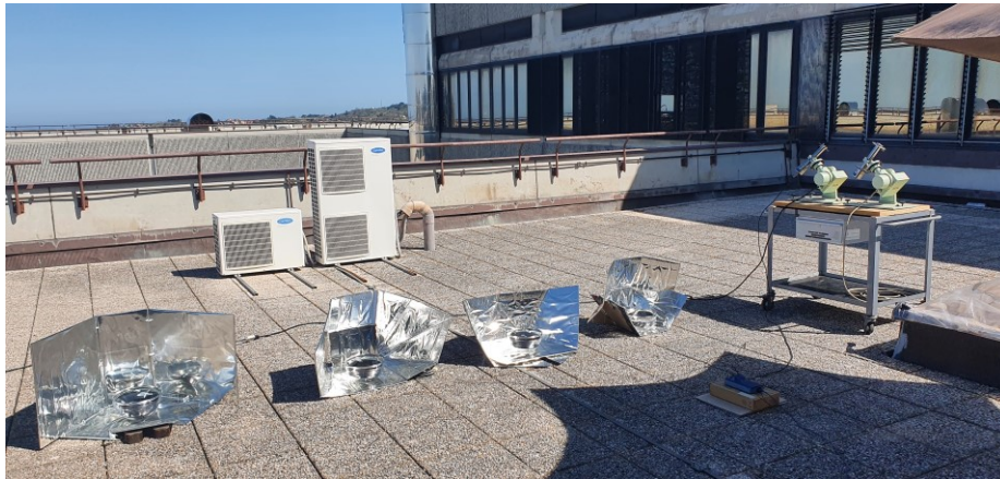
Figura 3.12 Setup dei forni
