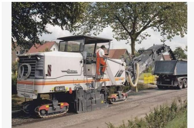
*Fig.12 Asportazione del conglomerato tramite fresa*
