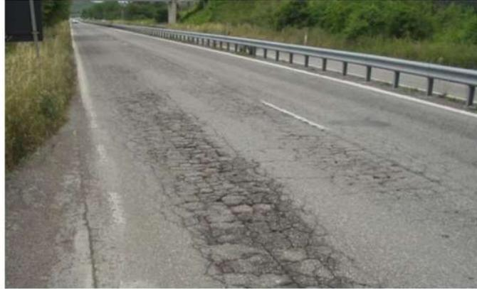
*Fig.11 Esempio fessurazione pavimentazione stradale*
