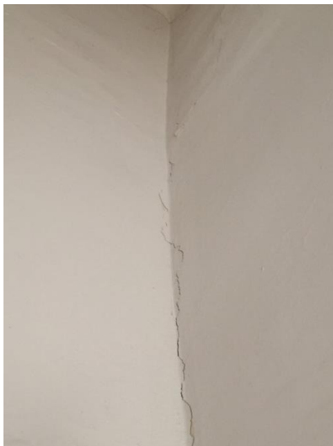
Figura 3.44: Rilievo del quadro fessurativo: foto: 83
