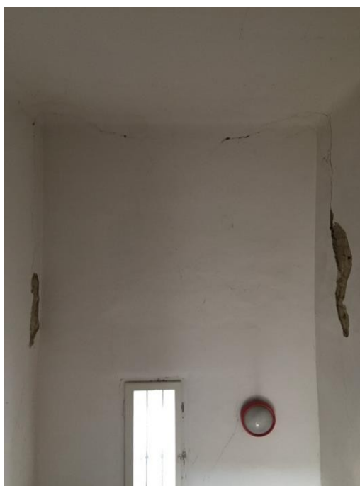
Figura 3.47: Rilievo del quadro fessurativo: foto: 90
