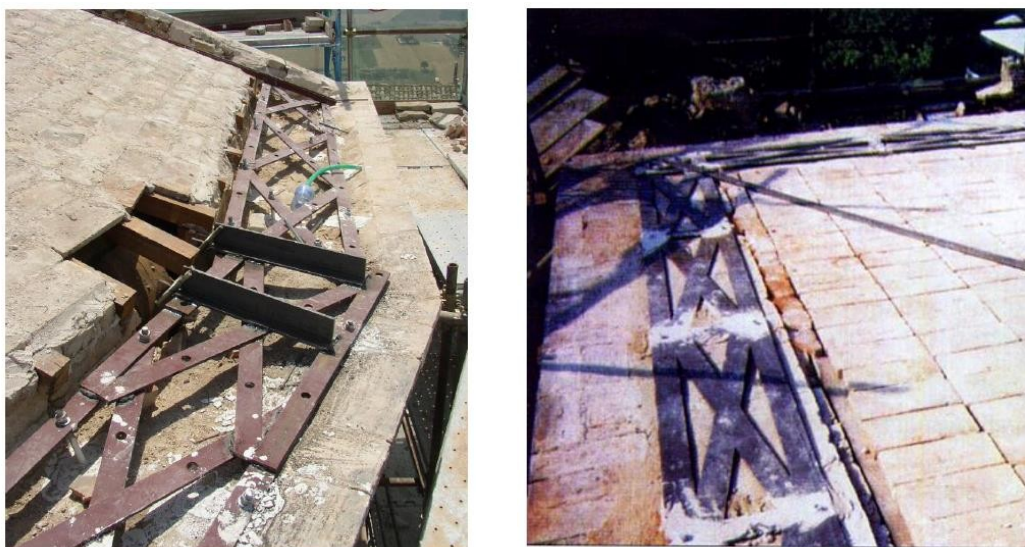
Figura 3.60: Esempi di intervento con cordoli tiranti adesivi in acciaio.
