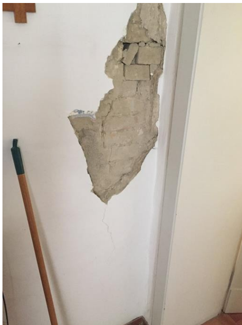
Figura 3.46: Rilievo del quadro fessurativo: foto: 116
