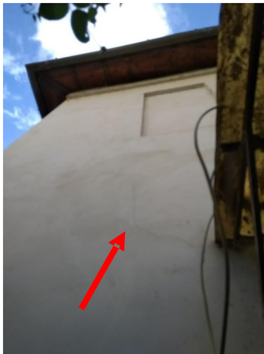
Figura 3.52: Rilievo del quadro fessurativo: foto: R
