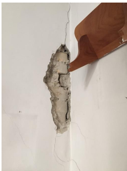
Figura 3.41: Rilievo del quadro fessurativo: foto: 33
