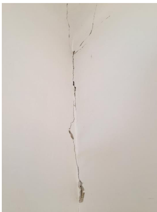
Figura 3.51: Rilievo del quadro fessurativo: foto: 201
