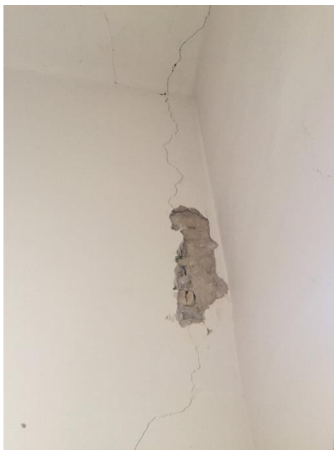
Figura 3.49: Rilievo del quadro fessurativo: foto: 89
