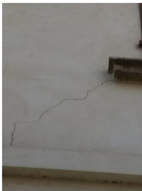
Figura 3.43: Rilievo del quadro fessurativo: foto: 1
