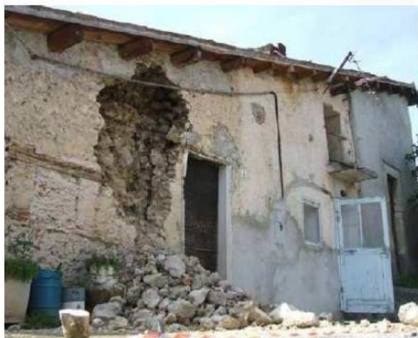
Figura 1.17 e 1.18: esempi di danneggiamento per disgregazione della tessitura muraria.
