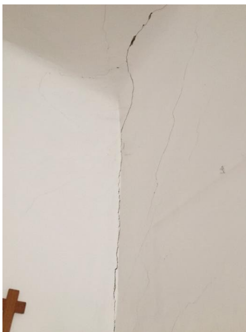
Figura 3.45: Rilievo del quadro fessurativo: foto: 114
