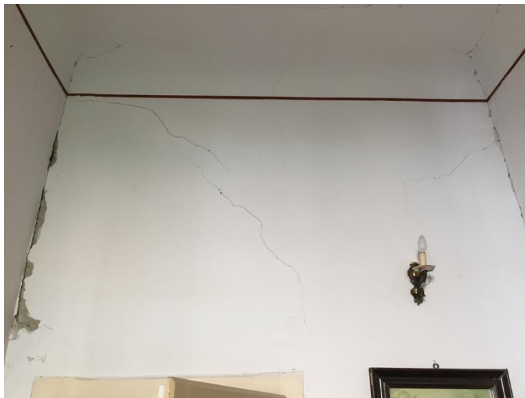
Figura 3.48: Rilievo del quadro fessurativo: foto: 157
