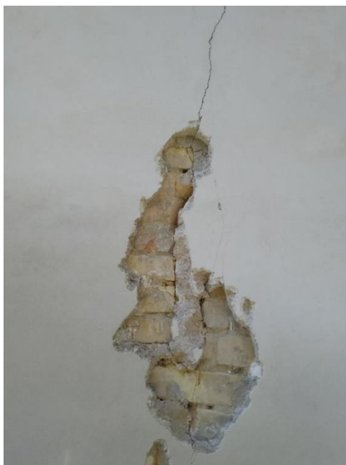
Figura 3.40: Rilievo del quadro fessurativo: foto: N
