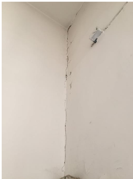
Figura 3.53: Rilievo del quadro fessurativo: foto: 170
