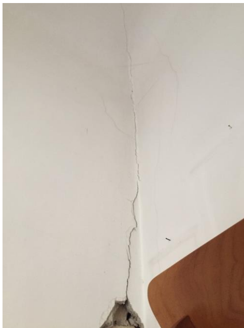
Figura 3.42: Rilievo del quadro fessurativo: foto: 34
