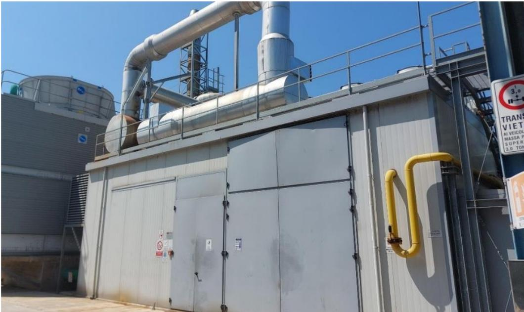
*FIGURA 8 COGENERATORE A SERVIZIO DEL PLANT DI ANCONA*
